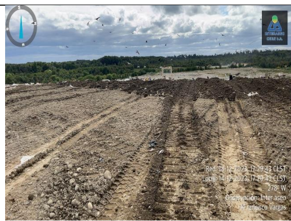
Cobertura terrea frente de trabajo
