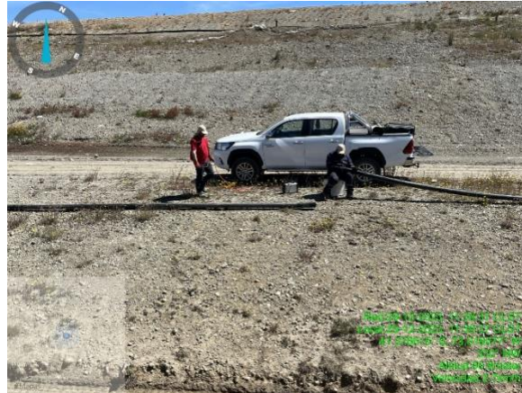
Construcción de ramal extra en HDPE
