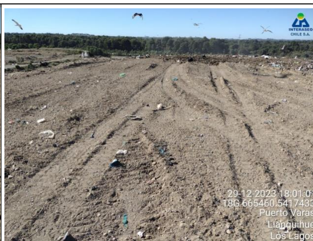
Cobertura terrea frente de trabajo
