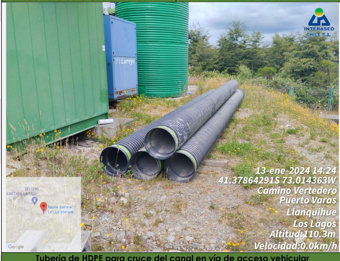
**Tubería de HDPE para cruce del canal en vía de acceso vehicular**
