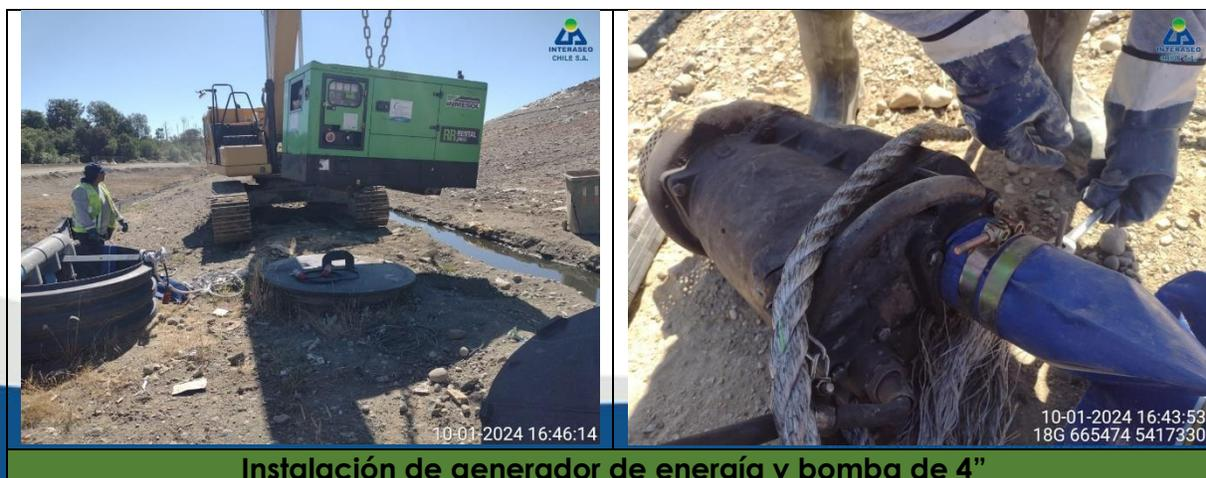
**Instalación de generador de energía y bomba de 4"**
