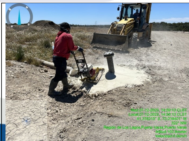
Mantenición de terminales de tubería
