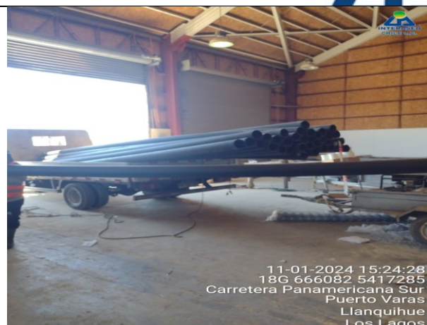
Recepción de tubería para empalmes
