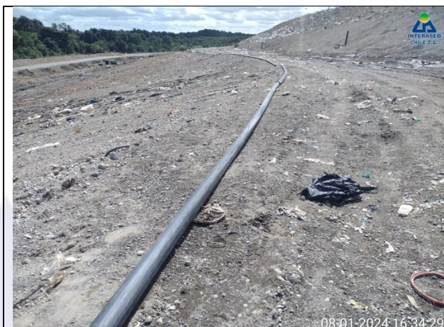
Extensión de tubería de empalme
