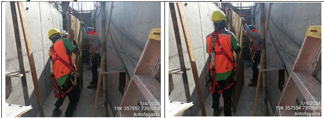
Figura 9. Fotografías biombos acústicos móviles en proceso de instalación
