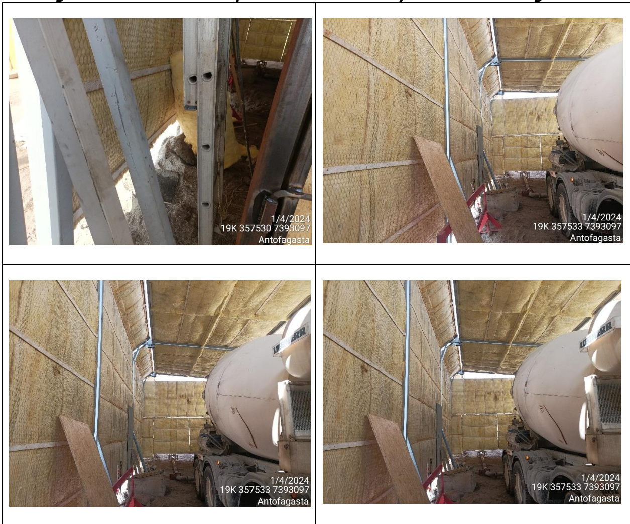
Figura 11. Túnel acústico para camiones mixer y bomba de hormigonado
