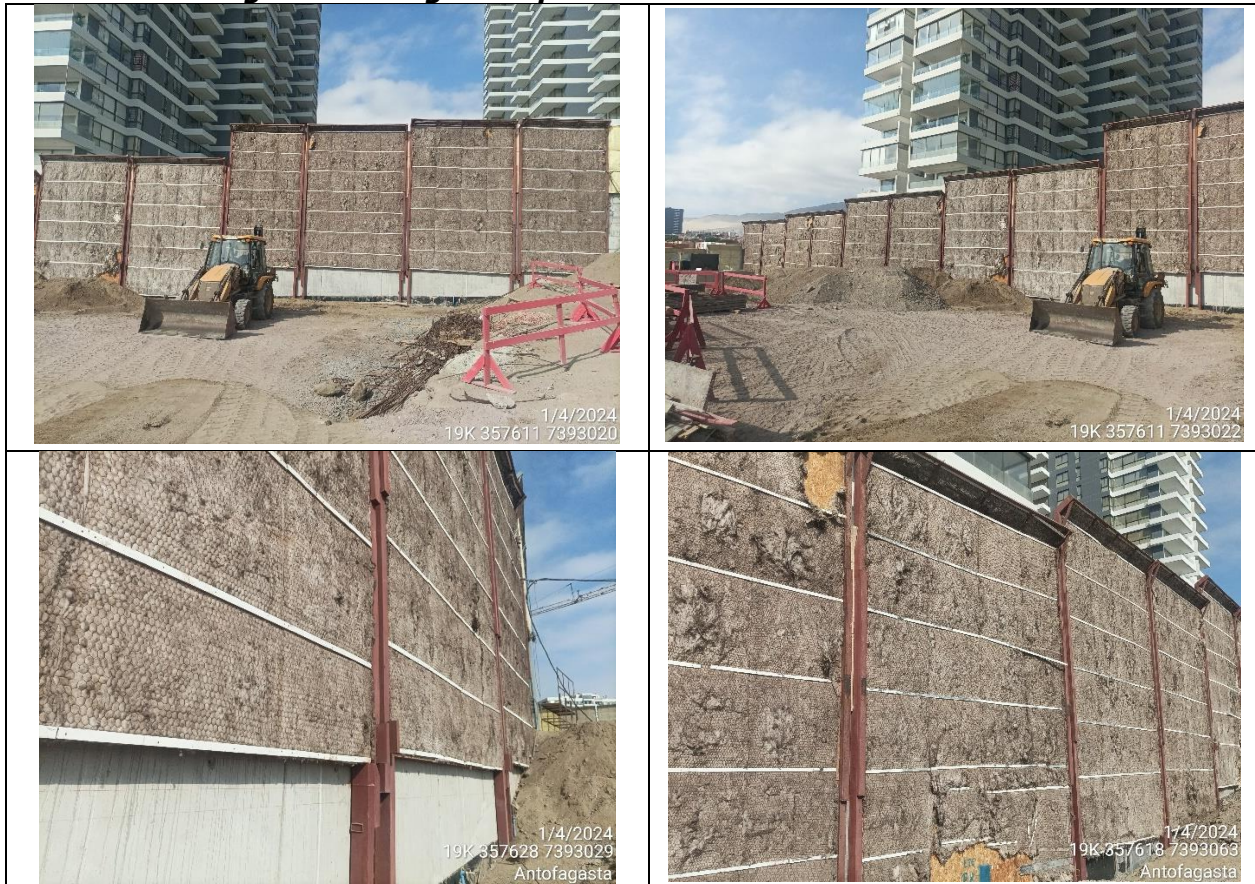
Figura 5. Fotografías pantallas acústicas sector Oriente
