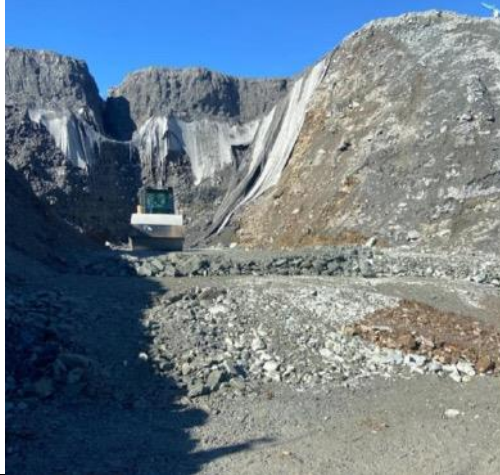
IMAGEN N°9. ÁREA DEL MURO UNA VEZ QUE SE RETIRÓ EL MATERIAL DESPLAZADO
