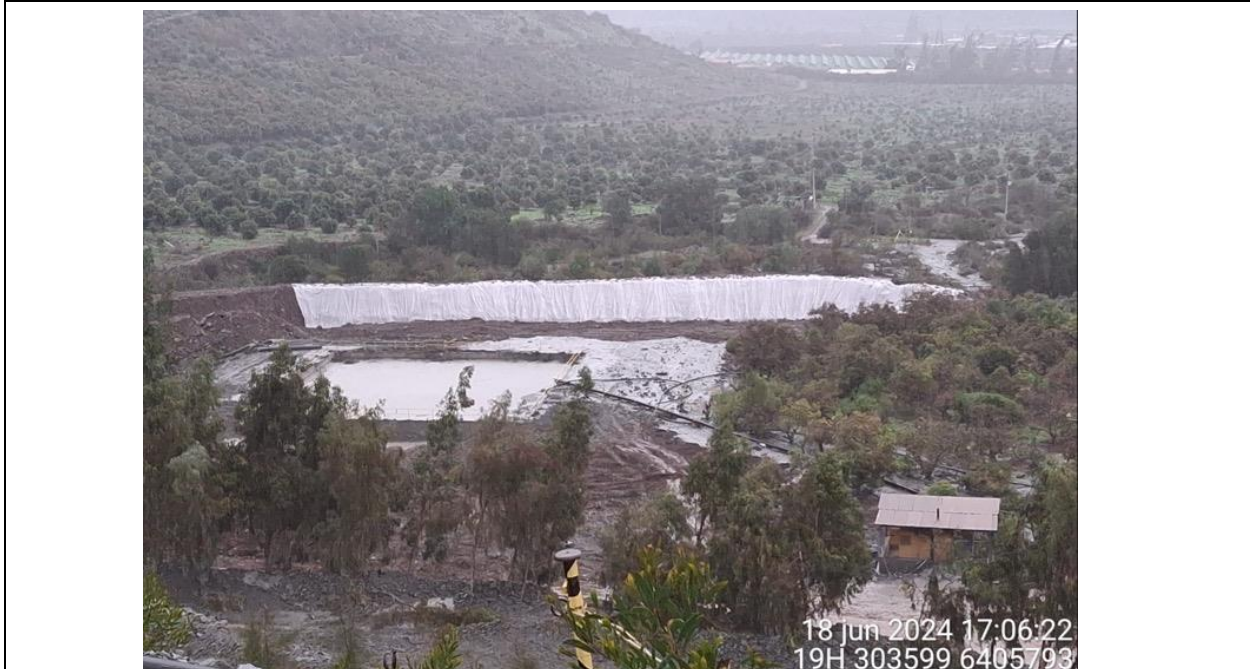
IMAGEN N°3. PRETEL DE CONTENCIÓN HABILITADO MARTES 18 DE JUNIO 2024
