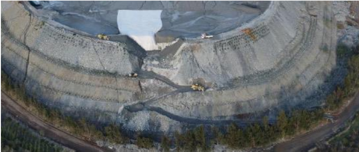
IMAGEN N°11. VISTA GENERAL PLATAFORMA DE DESCARGA HABILITADA PARA RECONSTRUCCIÓN DEL MURO
