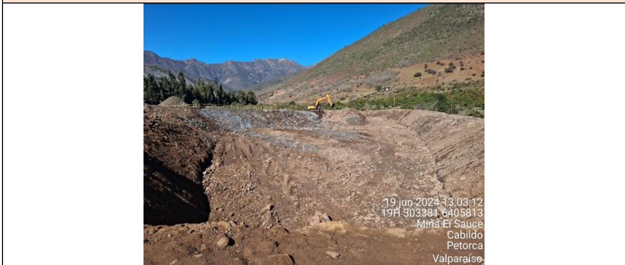
IMAGEN N°4. TRABAJOS DE REACONDICIONAMIENTO PRETEL DE CONTENCIÓN, MIÉRCOLES 19 DE JUNIO 2024
