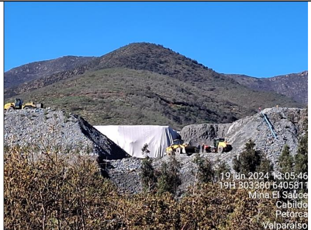
IMAGEN N° 18. TRABAJOS EN SEGUNDA ETAPA DE RELLENO Y COMPACTACIÓN DEL MURO.
