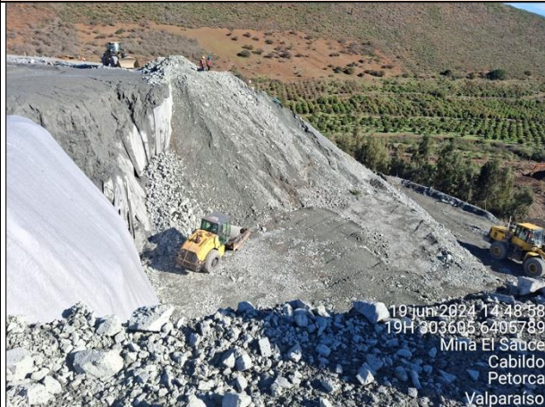
IMAGEN N° 17. TRABAJOS EN SEGUNDA ETAPA DE RELLENO Y COMPACTACIÓN DEL MURO.
