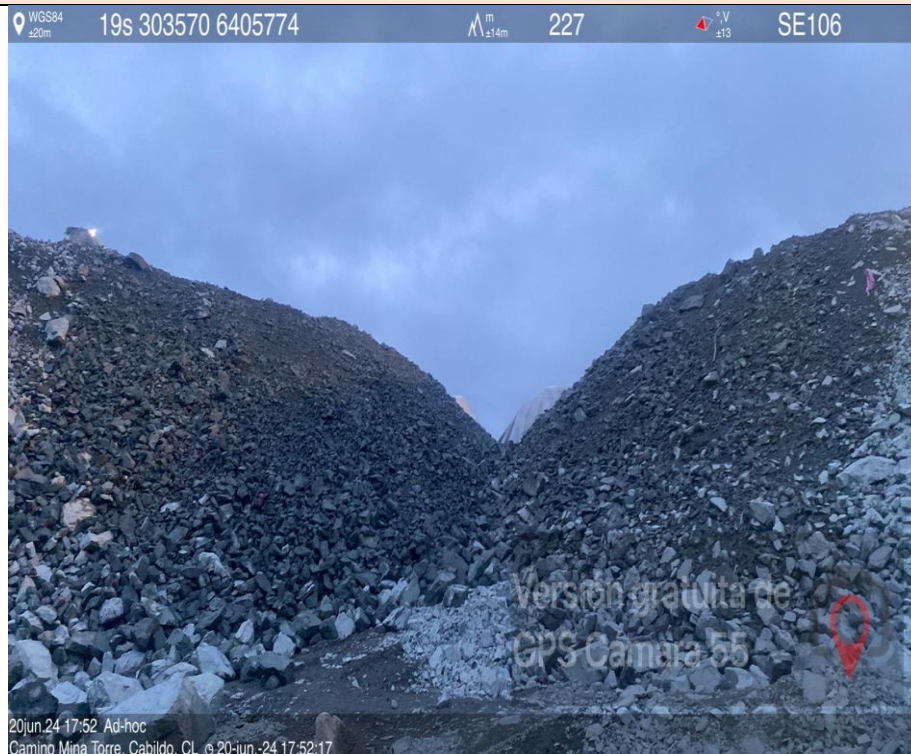
IMAGEN N° 19. TRABAJOS EN SEGUNDA ETAPA DE RELLENO Y COMPACTACIÓN DEL MURO
