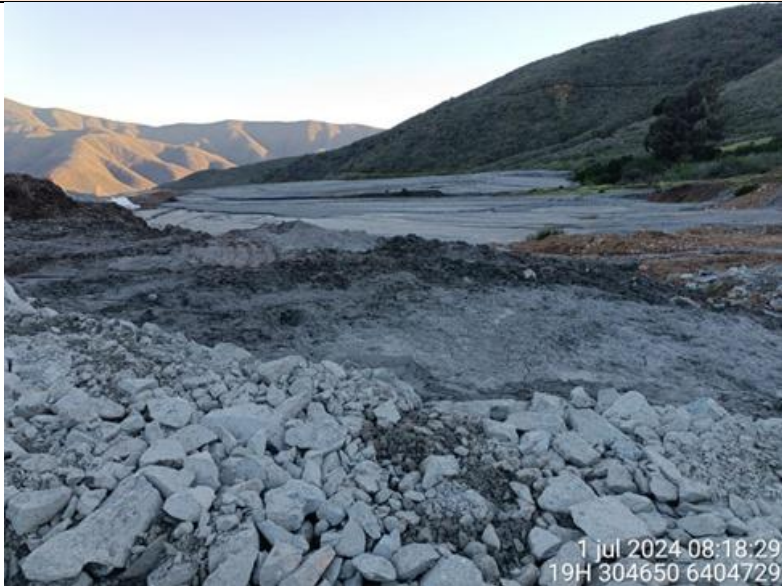
IMAGEN N°9. DISPOSICIÓN DE RELAVES EN EL LADO SUR DEL DEP
