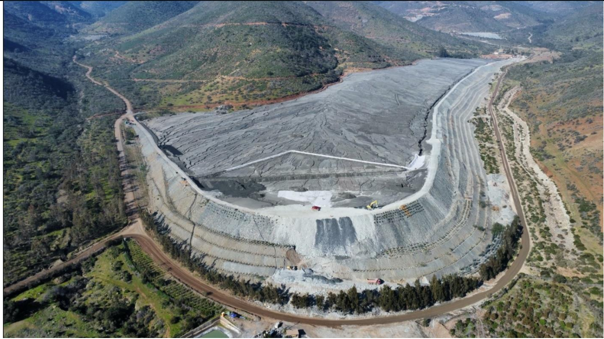
Imagen N°26. Estado de Reparación del Muro Depósito de Pasta 08.07.24
