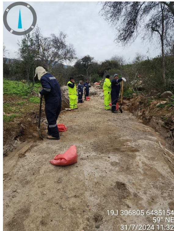
Figura N°3: Registro de Limpieza Área Seca
