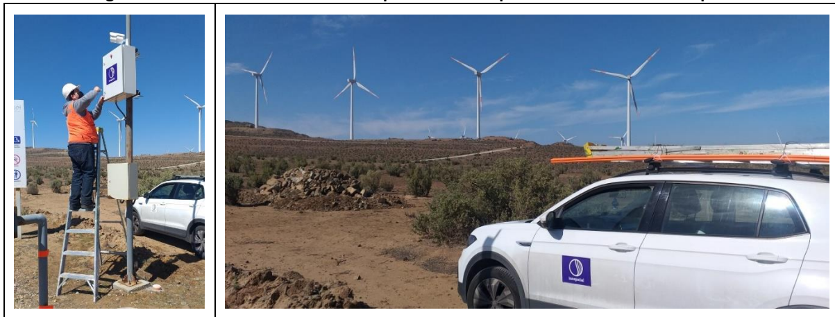
Figura 6. Instalación de cámaras de captura de video para el desarrollo de Birdspatial.
