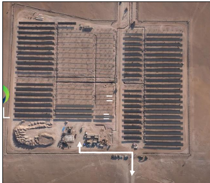
Figura 3: Ruta de Ingreso y salida del camión 3/4
