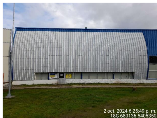
Sala de máquinas
