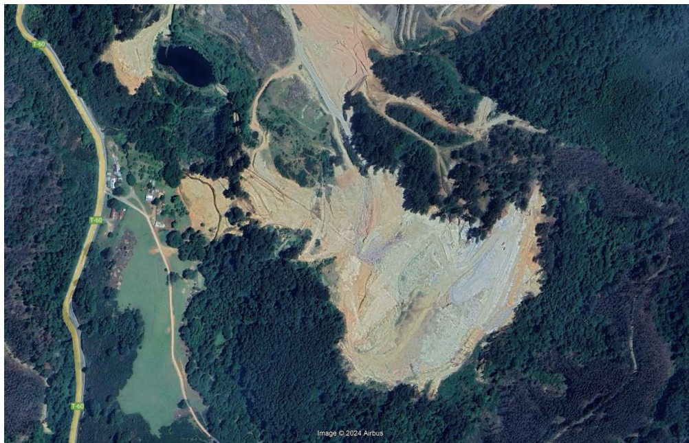
Figura 2. Ubicación del Vertedero de Morrompulli.
