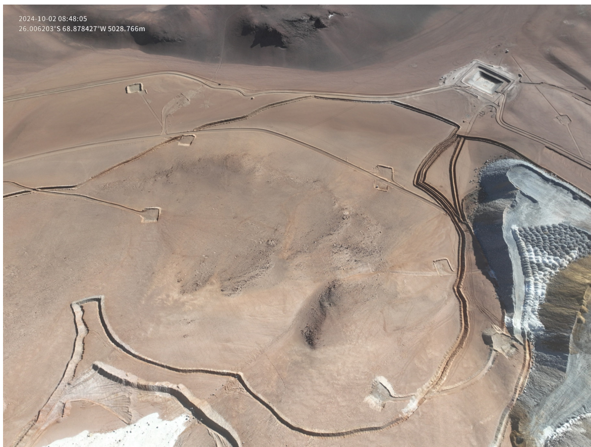
Figura 2: Fotografía tomada sobre el roquerío N°3 (día 02/10/2024)
