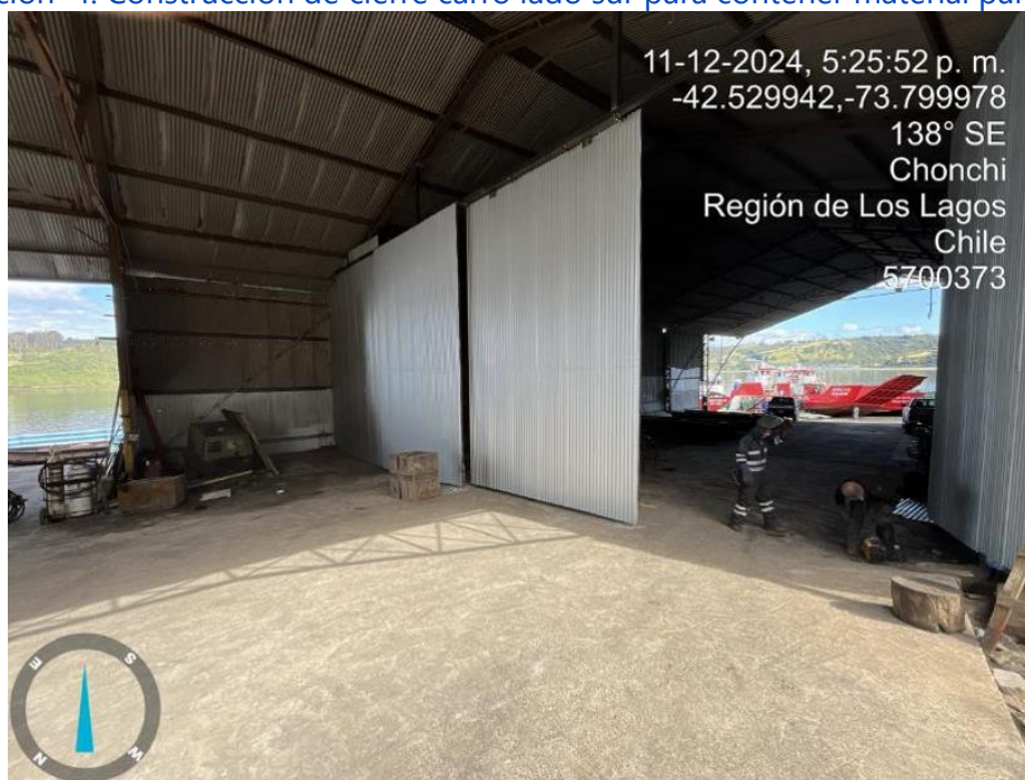
Ilustración 4: Construcción de cierre carro lado sur para contener material particulado
