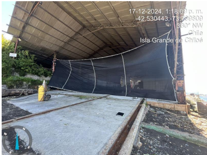
Ilustración 5: Instalación de Malla para la contención de material particulado galpón carro lado sur
