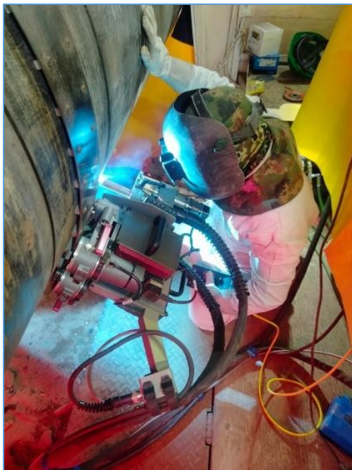
Ilustración 25. proceso de soldadura de tubería (imagen referencial)
