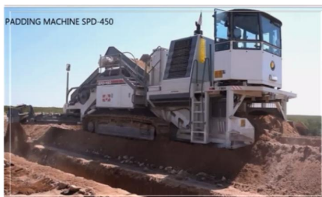
Ilustración 28. Tapado de Zanja (Imagen referencial).
