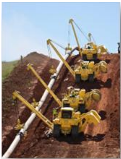
Ilustración 26. Bajada de tuberías (imagen referencial)
