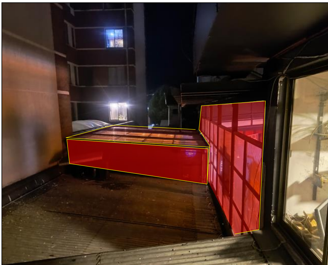
Figura 6. Ubicación transparencias acústica desde comedor 4(terrazza 1) del local hacia el exterior.
