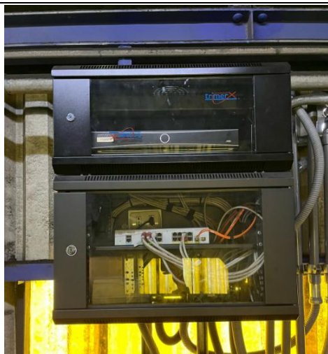
Imagen 14: Dispositivo de Almacenamiento (NVR) del CCTV
