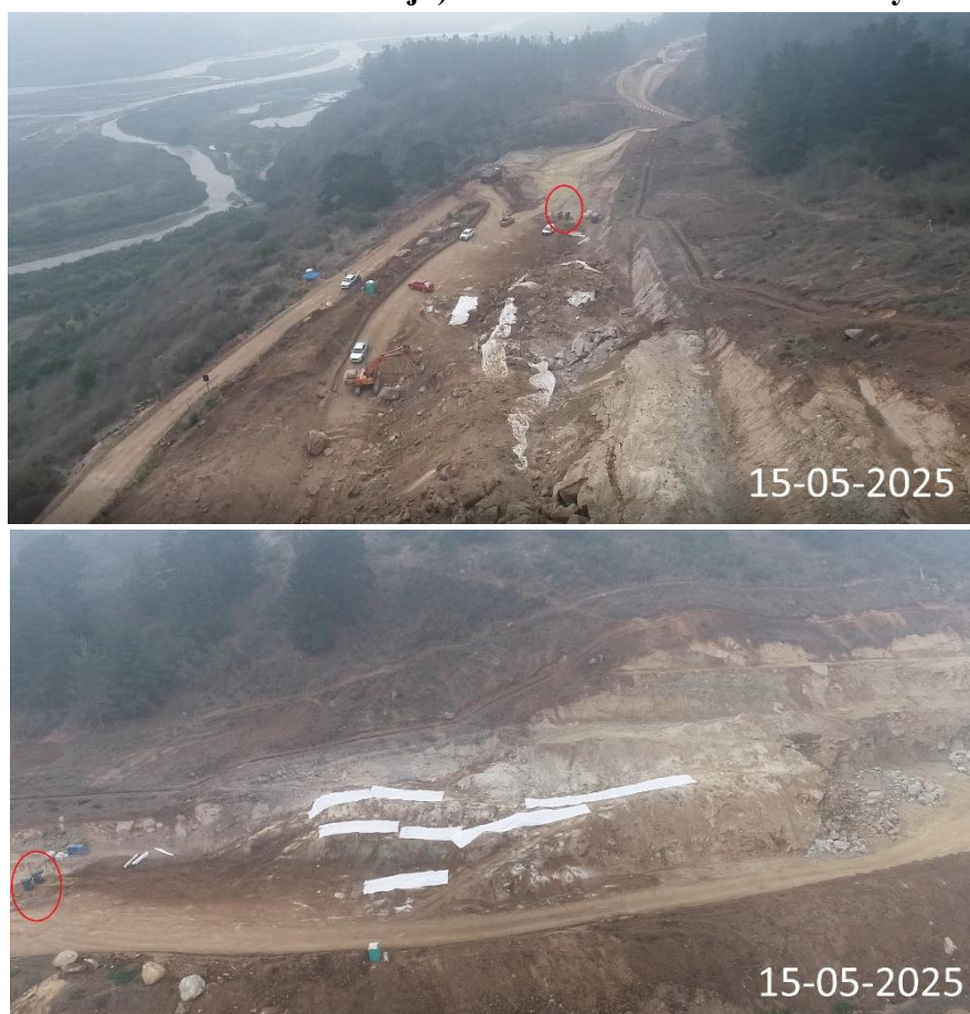
Figura: Coberturas de geotextil (cubierta de color blanco) y nebulizadores (identificador con un círculo rojo) en la tronadura del 15 de mayo de 2025
