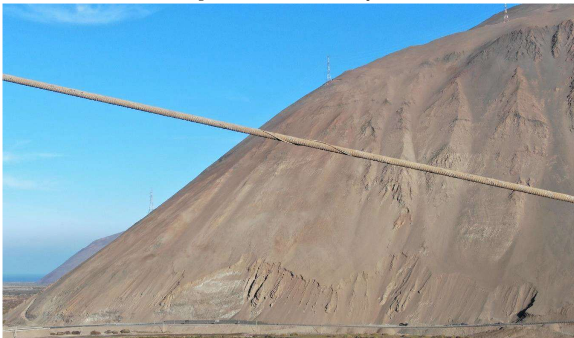
Imagen N°3: Hebra cortada en 2 puntos.
