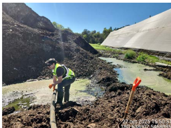
Imagen 8. Fotografía ANTES del retiro de residuos líquidos acumulados entre las pilas de compostaje
