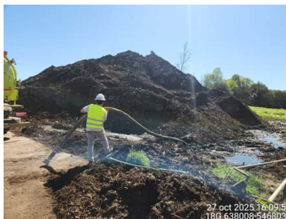
Imagen 9. Fotografía DESPUES del retiro de residuos líquidos acumulados entre las pilas de compostaje
