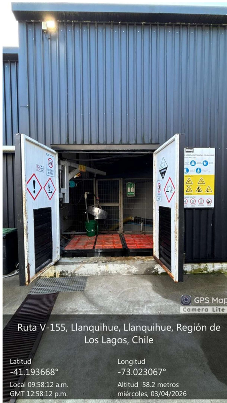
Imagen 1. Bodega de sustancias peligrosas tras retiro de formalina (4 de marzo de 2026).
