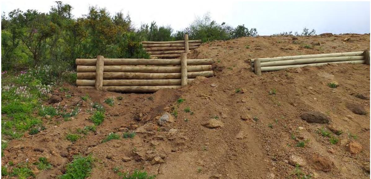
Fotografía 6. Obras de contención de taludes estructura 194 AMRA
