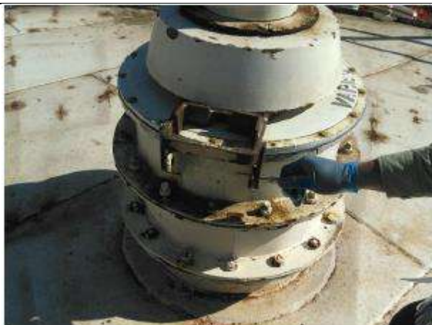
Fotografía 2 Se evidencia tapa si pasador
