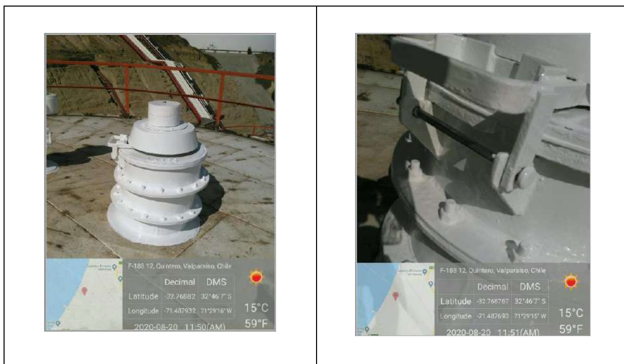
Figura 4-4: Pasador reparado en válvula de alivio de emergencia estanque E-202
