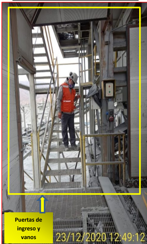
Previo a la ejecución de los trabajos
