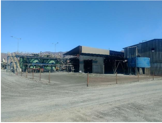
Celdas de flotación
