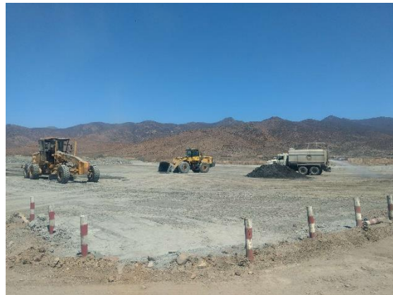
Maquinaria en cancha de acopio
