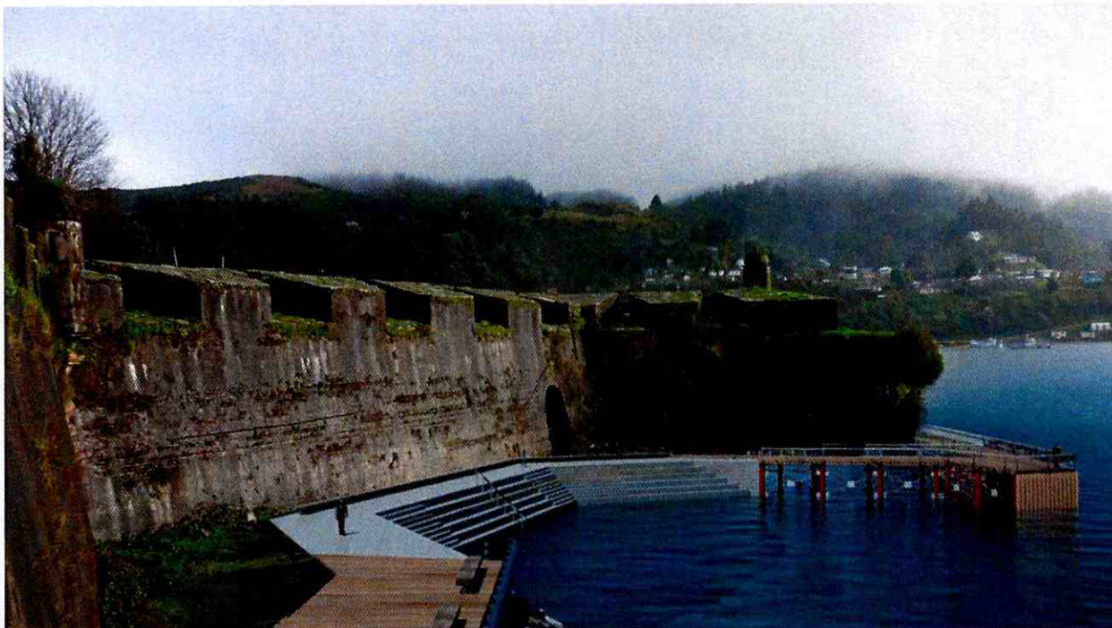
Figura 1. Foto 3 D de la obra de protección en el fuerte Corral.
