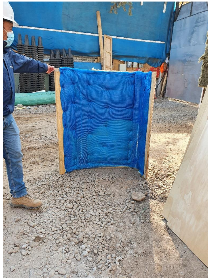
Figura 4. Biombo acústico – Fuente: Inspección en terreno.
