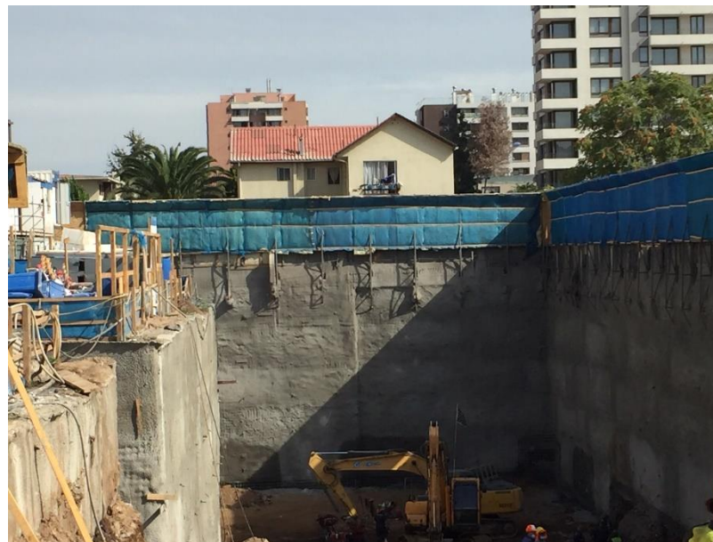
Figura 2. Cierre perimetral en el contorno de la construcción – Fuente: Entregado por el titular.
