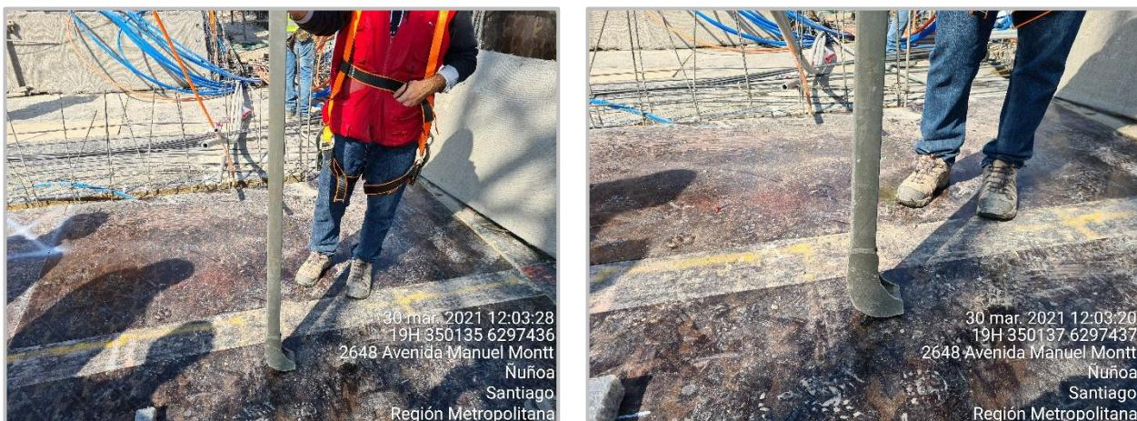
Siguiendo la recomendación de la Resolución Exenta N°592, la empresa constructora reemplaza el esmeril angular por una herramienta saca dowel manual.
