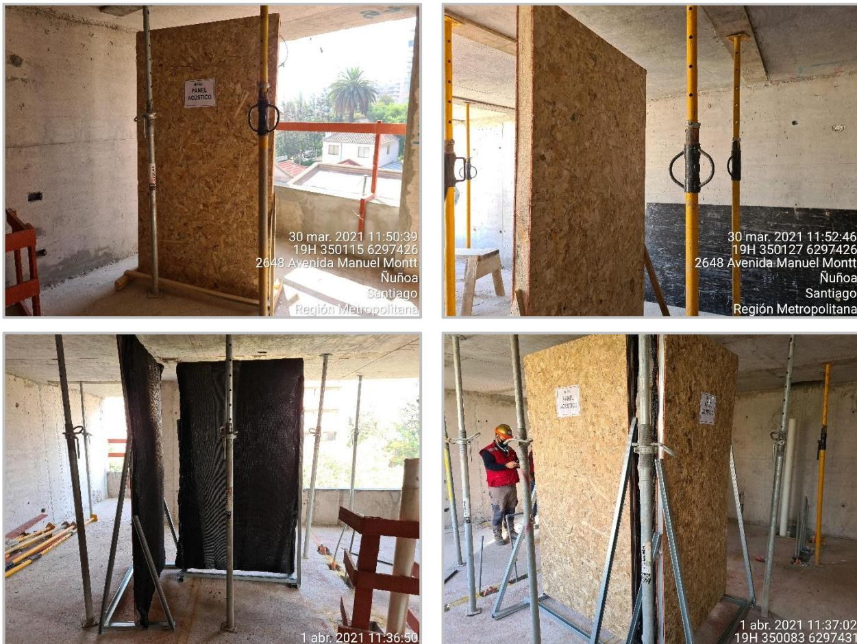
Durante los días 1 y 2 de medición (30/03/21 y 31/03/21), se constata la implementación de paneles acústicos sellados con planchas de madera por ambas caras instalados en losa de avance. Para el día 3 (01/04/21), los paneles son modificados siendo compuestos por una plancha OSB cubierta por manta aislante termo acústica y malla raschel.
