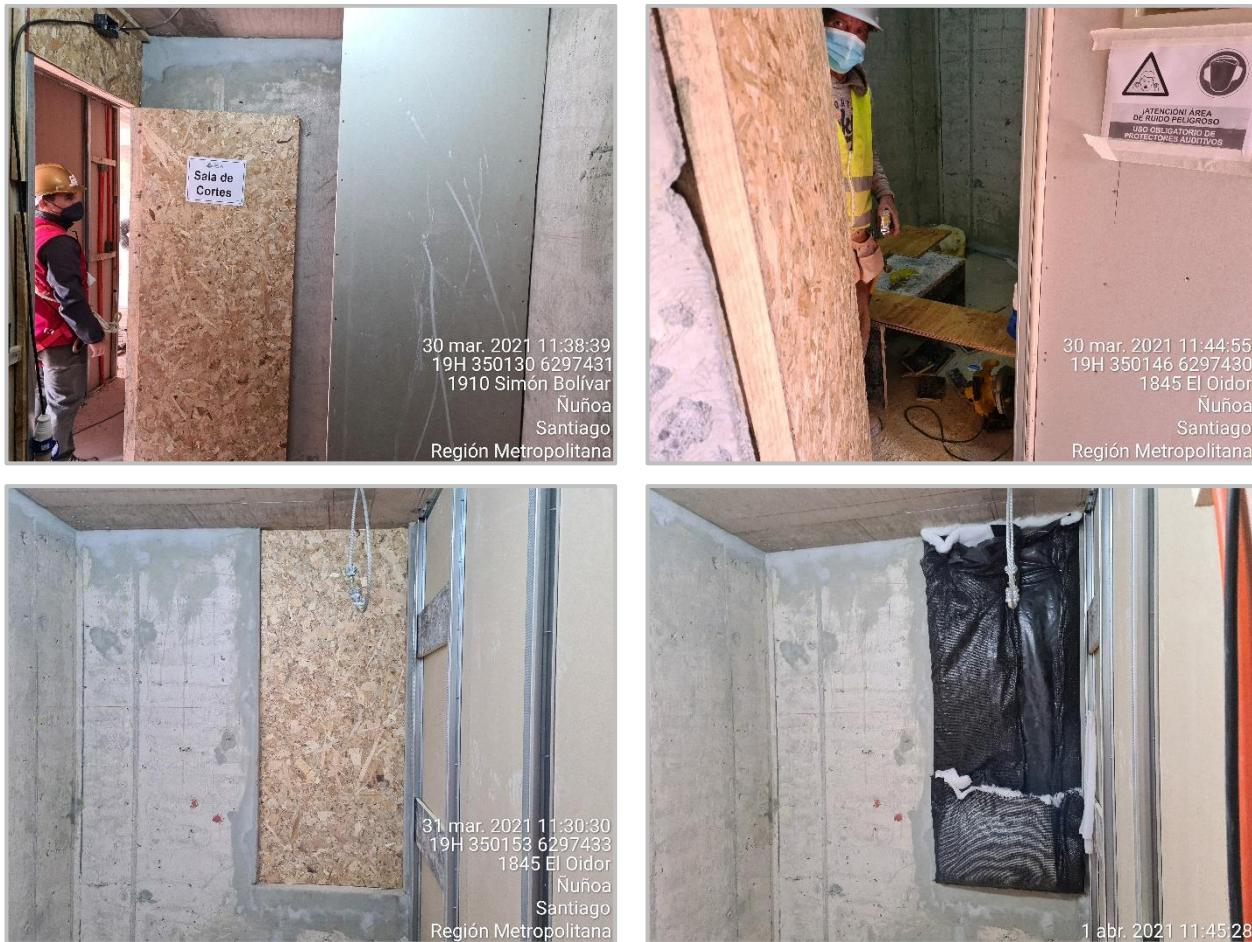
Durante los días 1 y 2 de medición (30/03/21 y 31/03/21), se constata la existencia de un taller de corte sellado con planchas de madera. Para el día 3 (01/04/21), la plancha de madera que cubre un vano es cubierta por aislante termoacústico y malla raschel.
