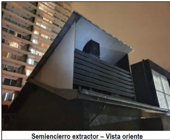
Figura 3. . Fuentes de ruido con medida de control semiencierro. Fuente: entregado por el titular.
