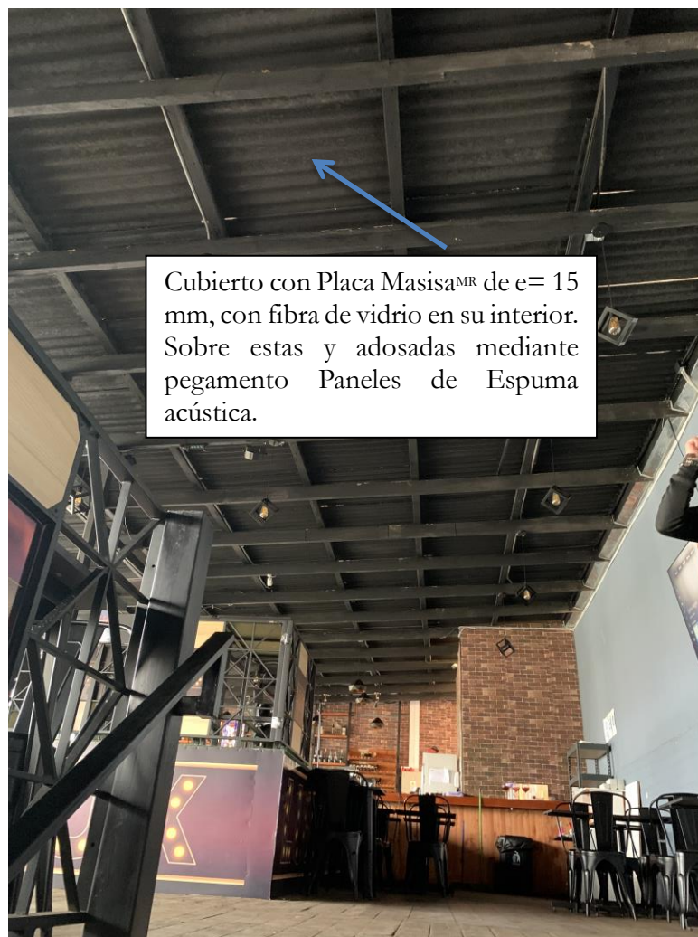
Imagen 10: Terraza, Refuerzo de cielo.
