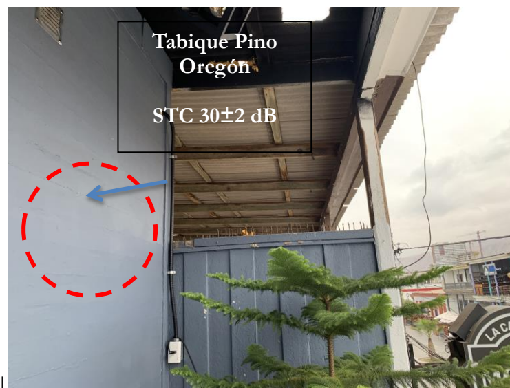
Imagen 8: Tabiques STC 30 \pm 2 \text{ dB} y Cielo STC 25 \pm 2 \text{ dB} (INSUL)
