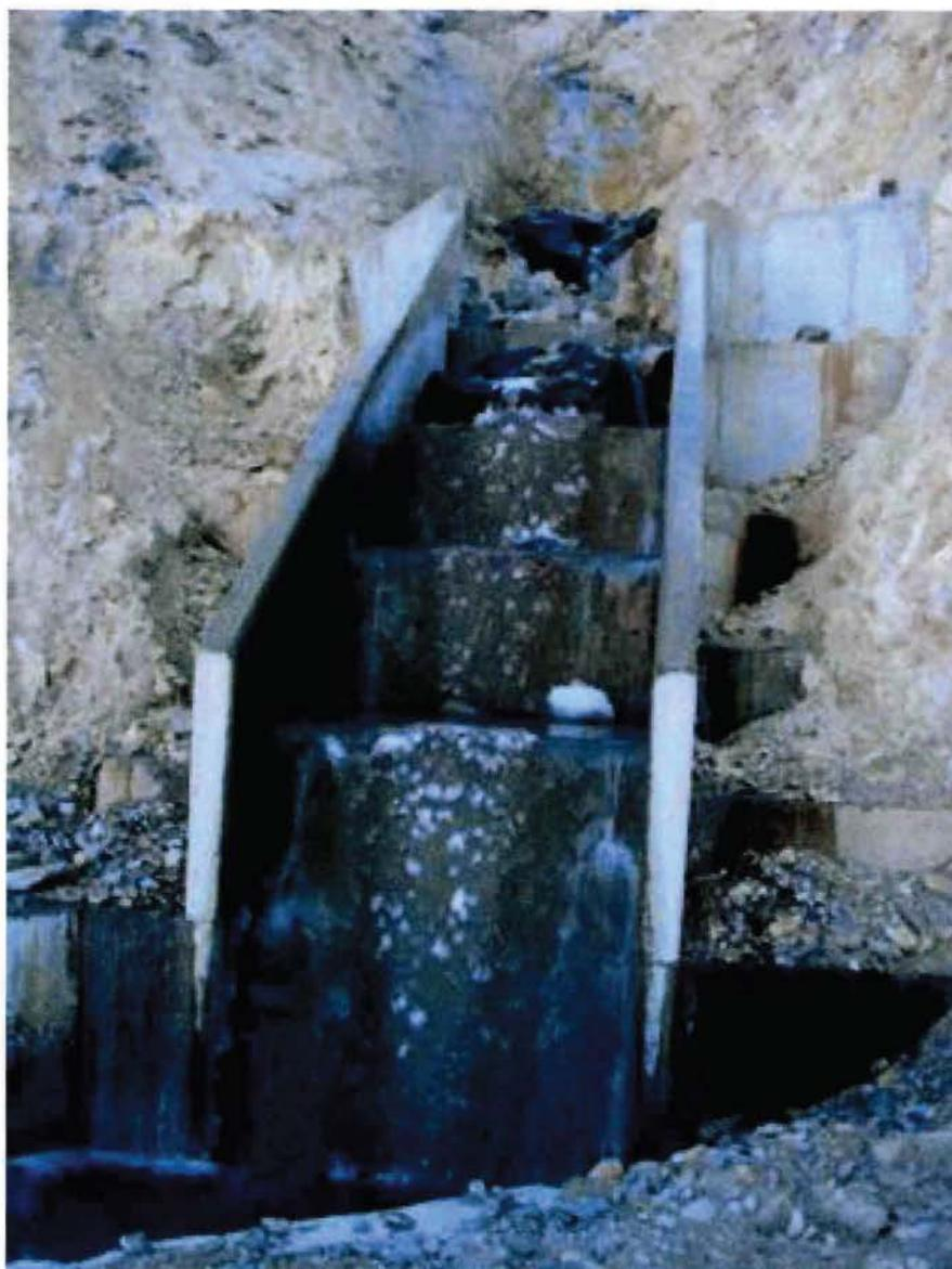
Fotografía N°2: Obra de entrada canal perimetral norte inferior
