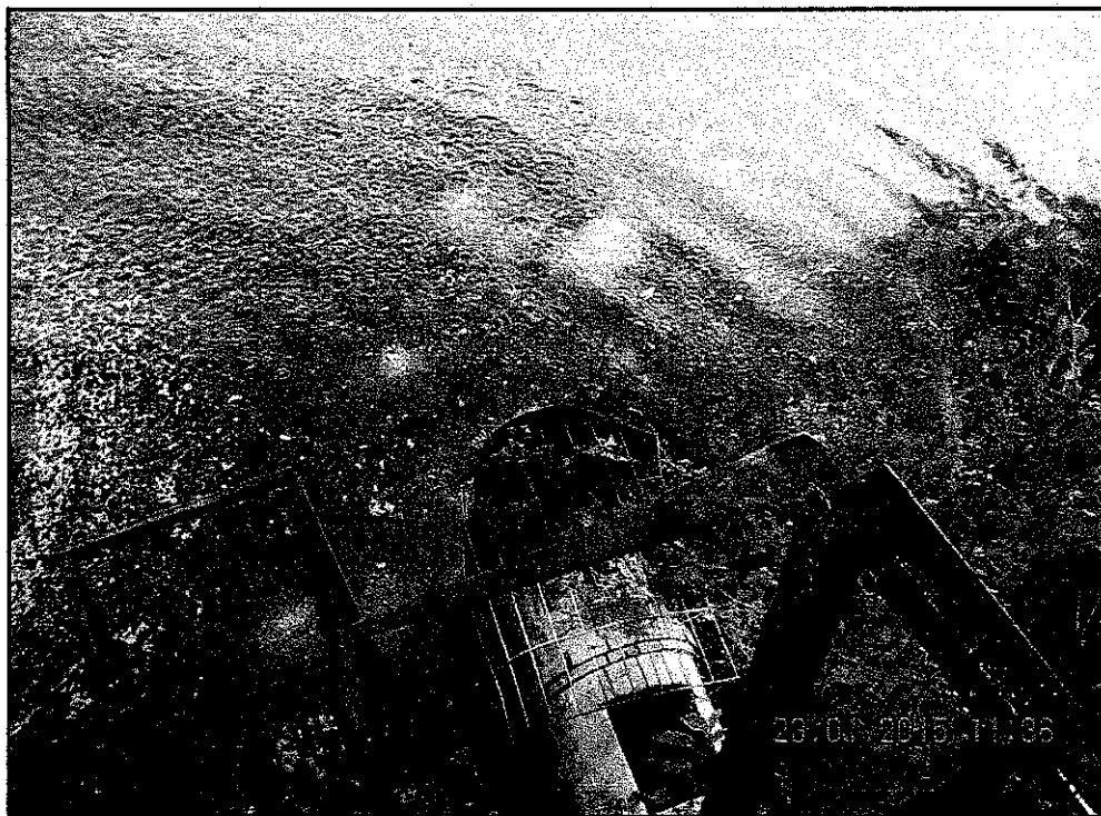
Sistema de aspersión instalado en la descarga para disipar las espumas en el estero Botorlhue
