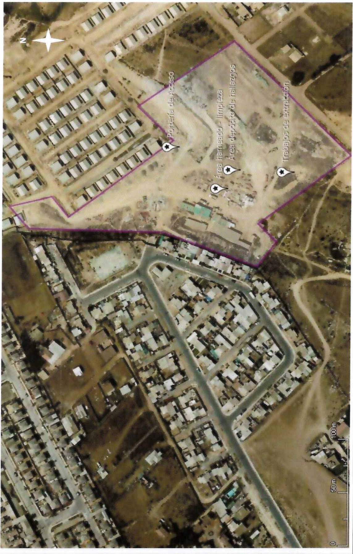
Figura 3. Recorrido de la inspección
