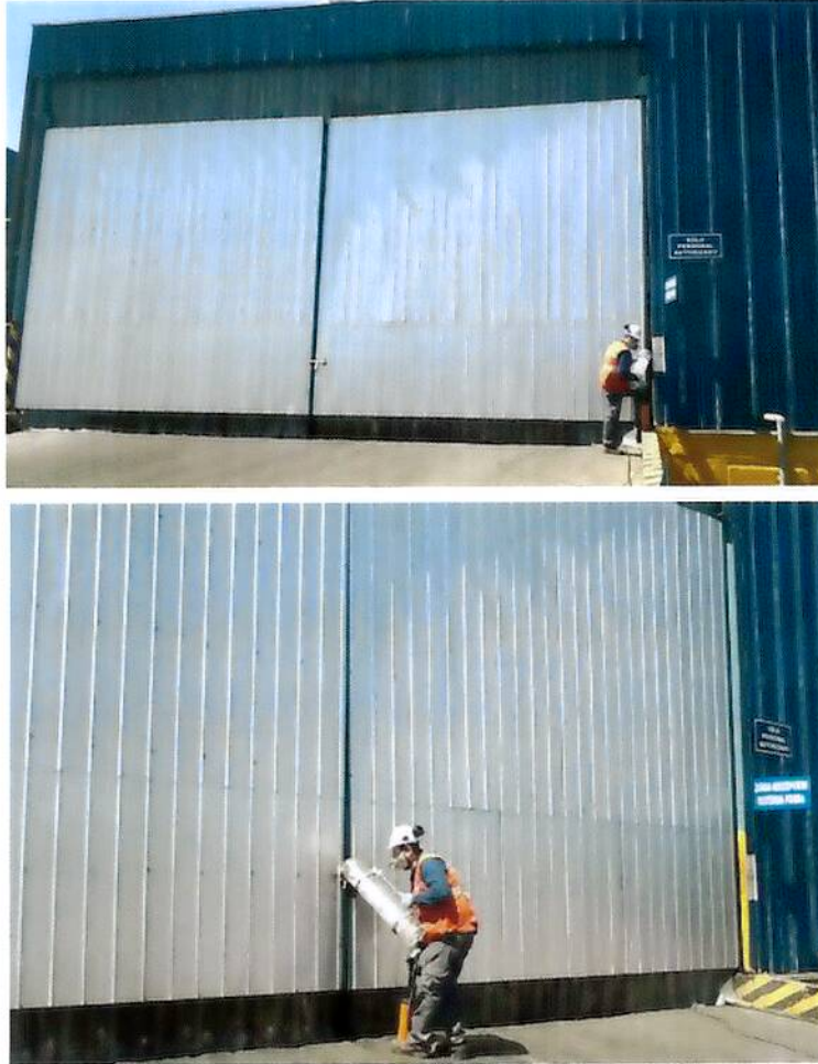
Figura 13. Mediciones en el Galpón de Recepción de Materias Primas.
