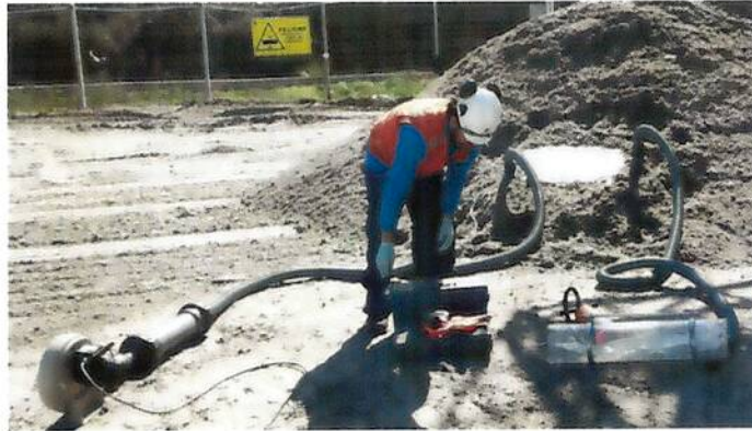
Figura 4. Unión tubos corrugado de PVC.
