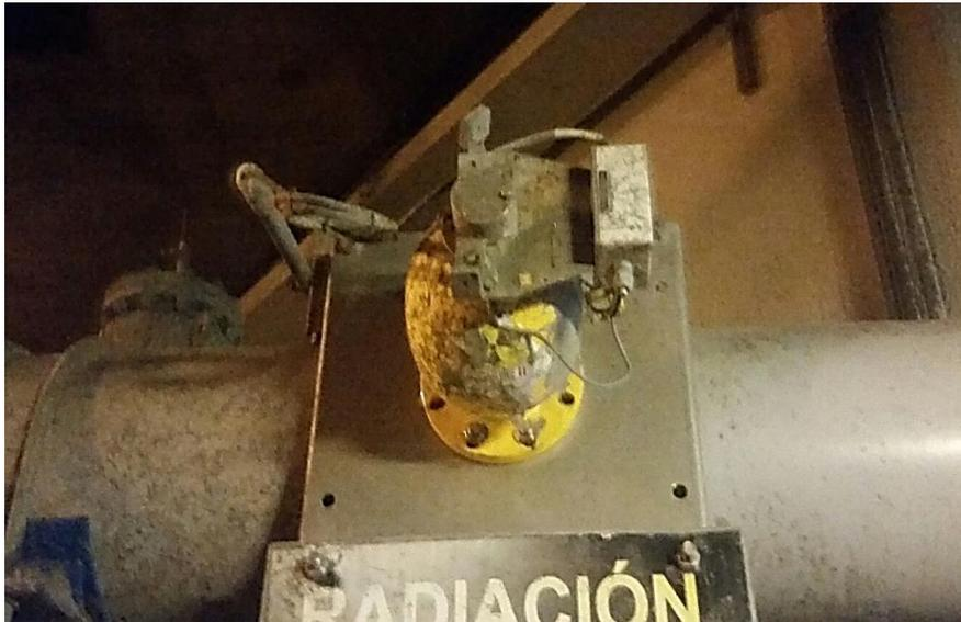
**Figura 3:** Densímetro en línea descarga de bombas de relaves
