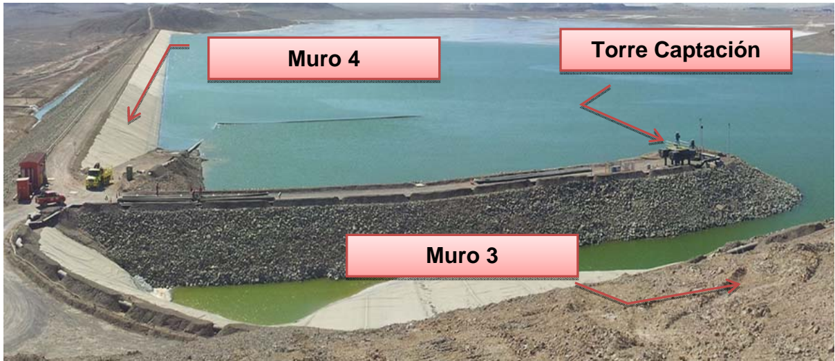
Imagen N°1 torre captación de depósito de relaves.
