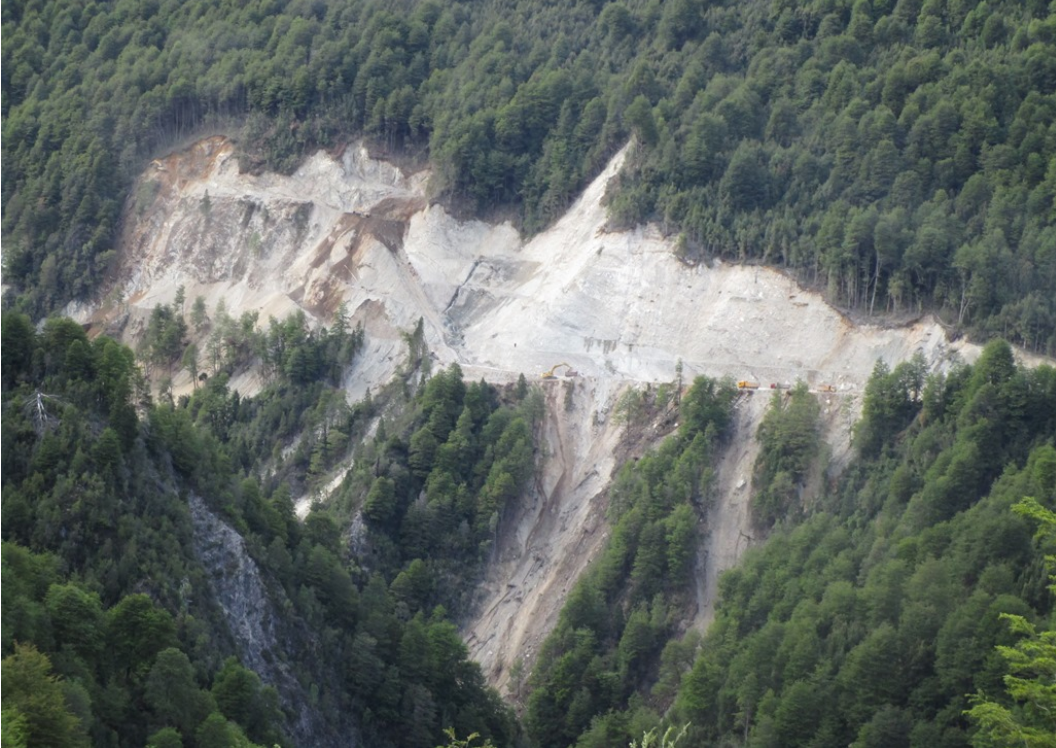
Km 14,4 Talud en construcción Tigre Sur, Coordenadas 19 G 255.688 E – 5.384.308 N. Vista desde el norte Obras Tigre Sur.
