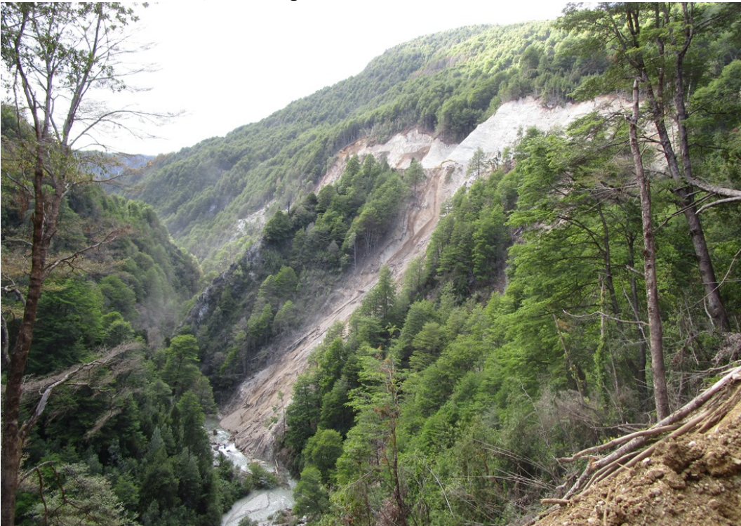
Km 14,4 Talud en construcción Tigre Sur, Coordenadas 19 G 255.688 E – 5.384.308 N. Vista desde el Noroeste , Ladera Tigre Sur
