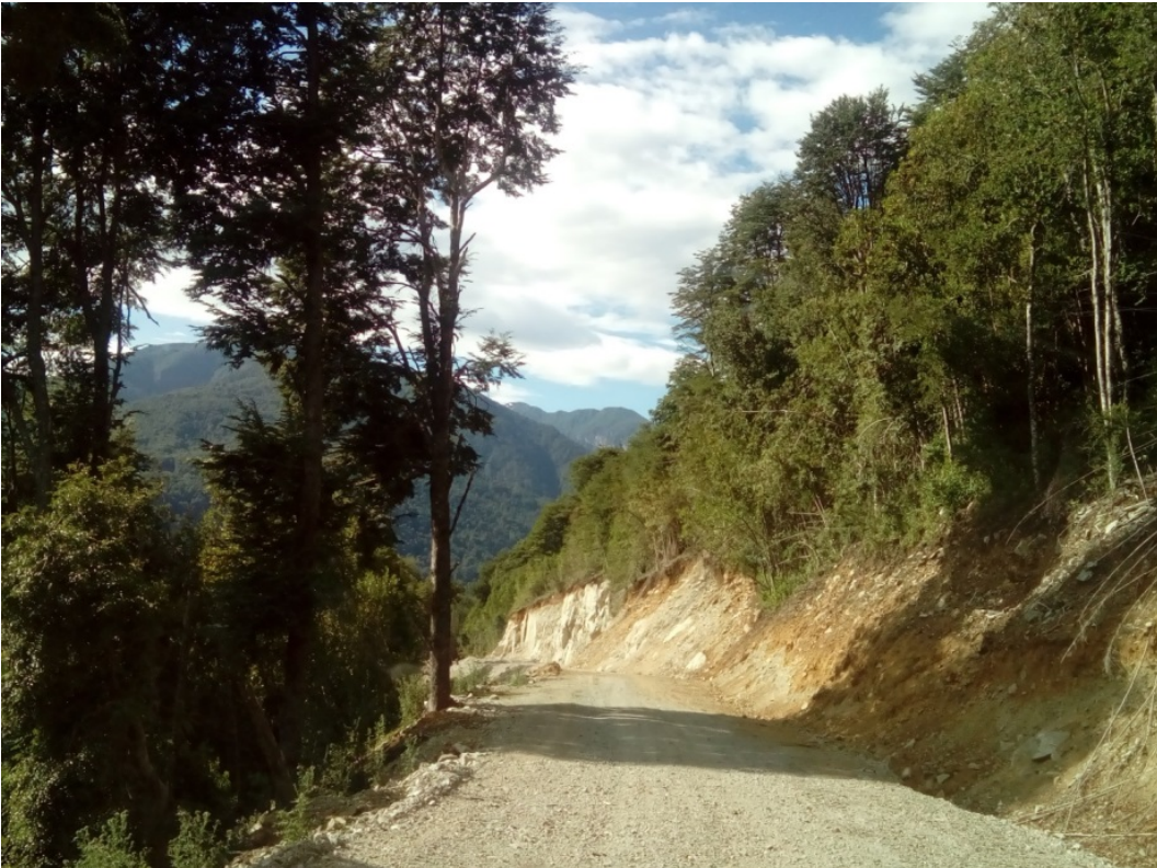
Km 11,0 Coordenadas 19G 254.663 E – 5.382.309 N.
