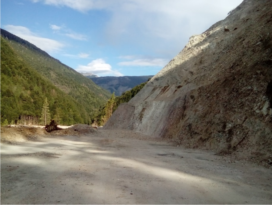
Km 14,3 Coordenadas 19G 255.206 E – 5.384.520 N.
