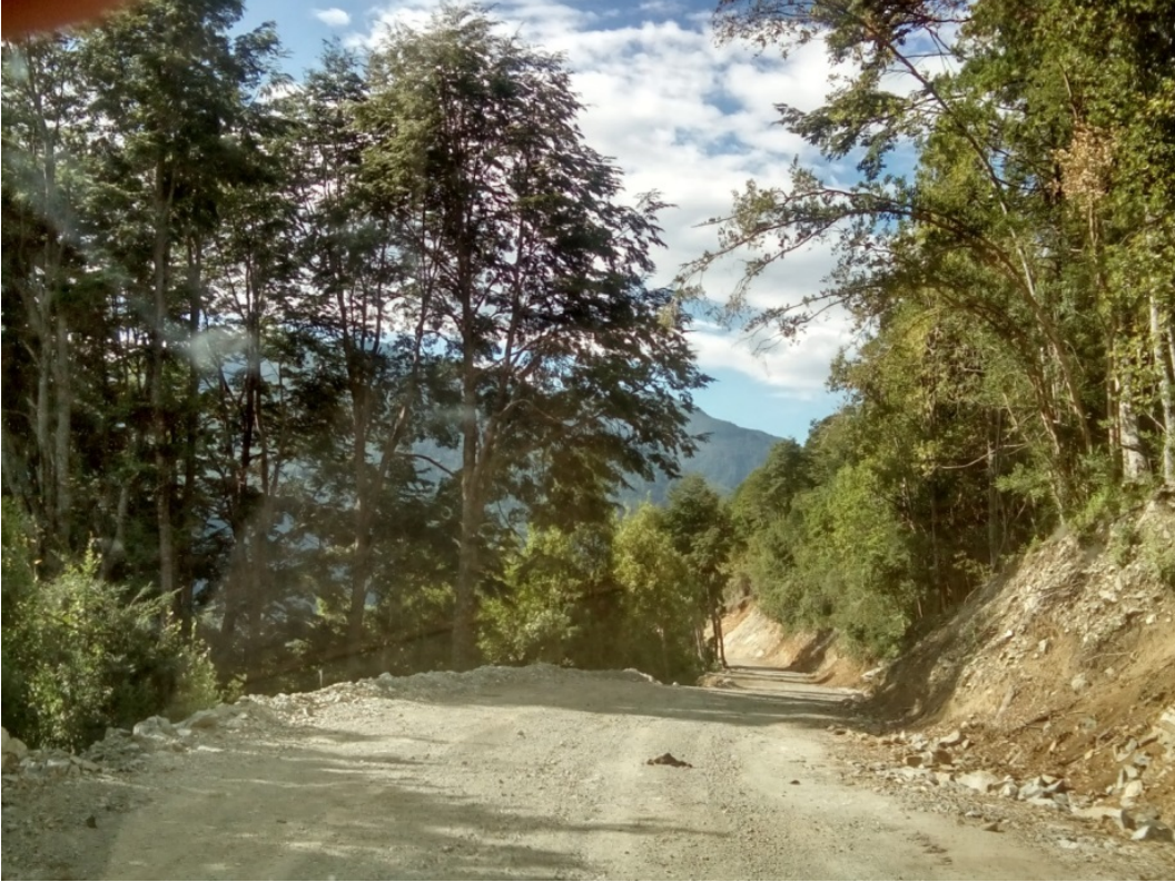
Km 10,9 Coordenadas 19G 254.677 E – 5.382.171 N.
