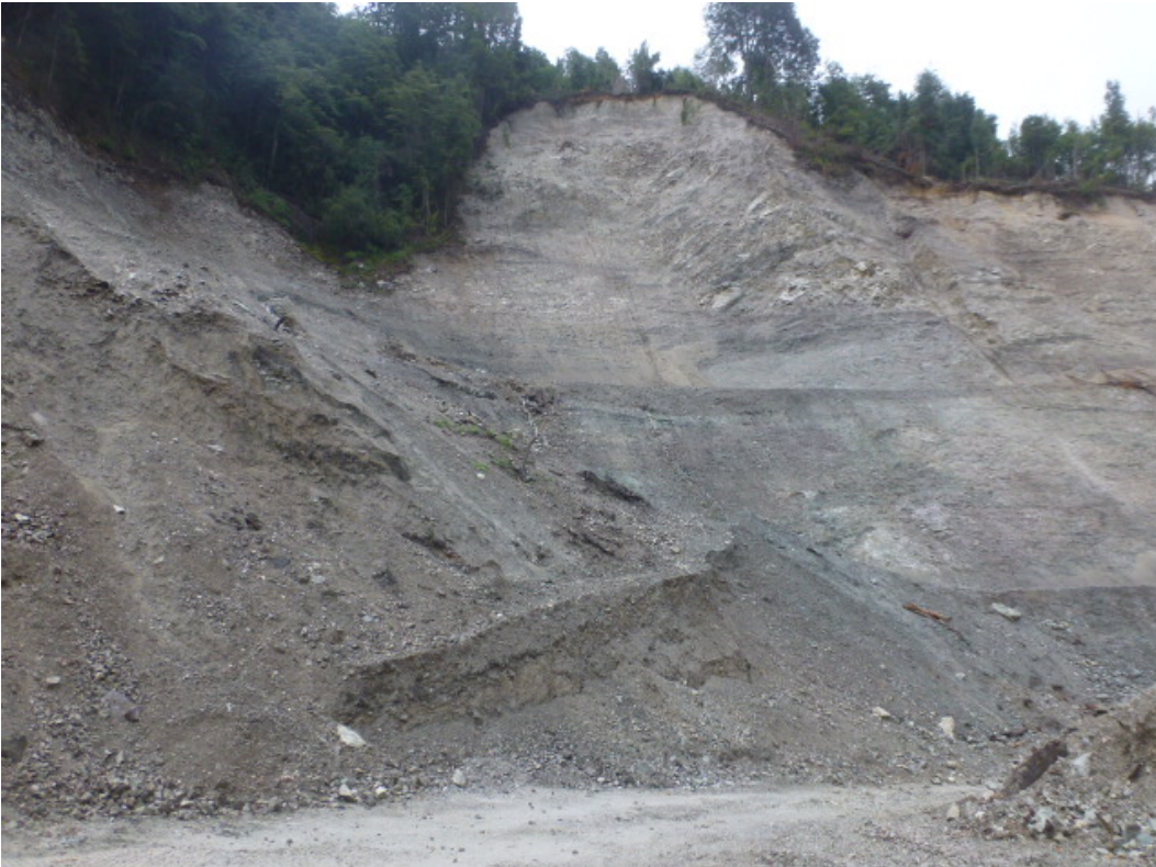
Km 14,4 Talud en construcción Tigre Sur, Coordenadas 19 G 255.688 E – 5.384.308 N.
