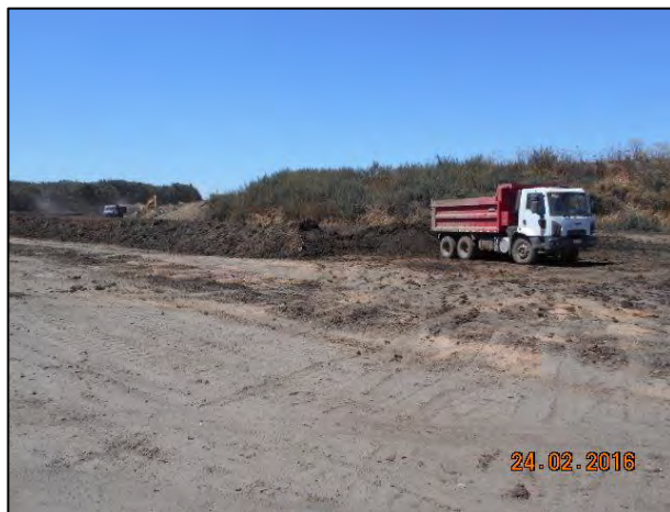
Conformación de pilas con lodos provenientes de piscinas y acopio de invierno
