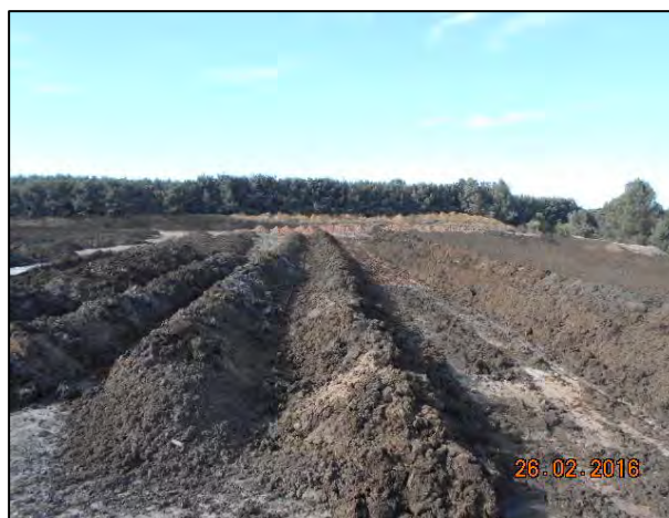
Conformación de pilas y secado de lodos del sector 3
