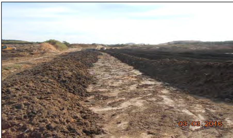
Conformación de pilas y secado lodos de acopio de invierno
