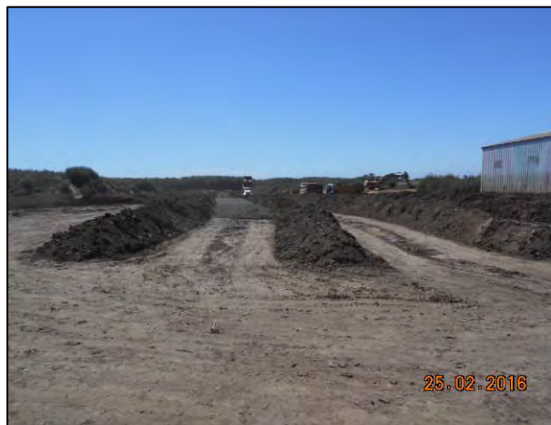
Conformación de pilas con lodos provenientes de piscinas y acopio de invierno
