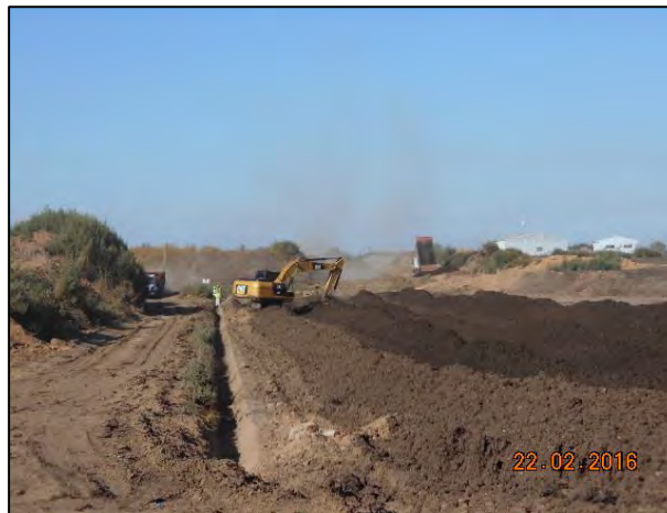
Conformación y secado de lodos
