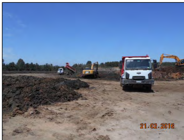
Conformación de pilas con lodos vaciados
