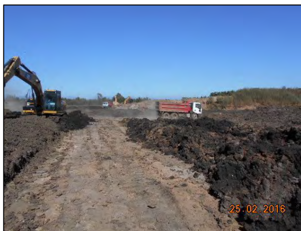
Conformación de pilas acopio de invierno
