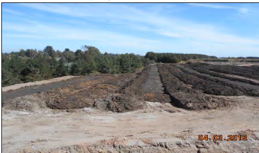
Conformación y secado de pilas lodos piscina sector 3
