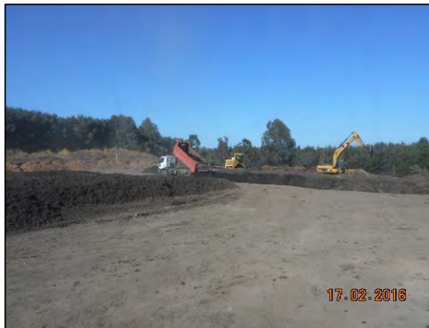
Conformación y secado de pilas sector 3
