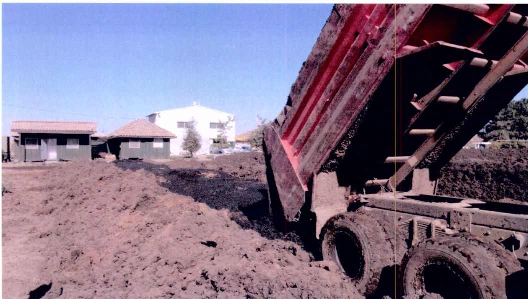
Figura 11. Vista disposición de lodos en canchas de secado
