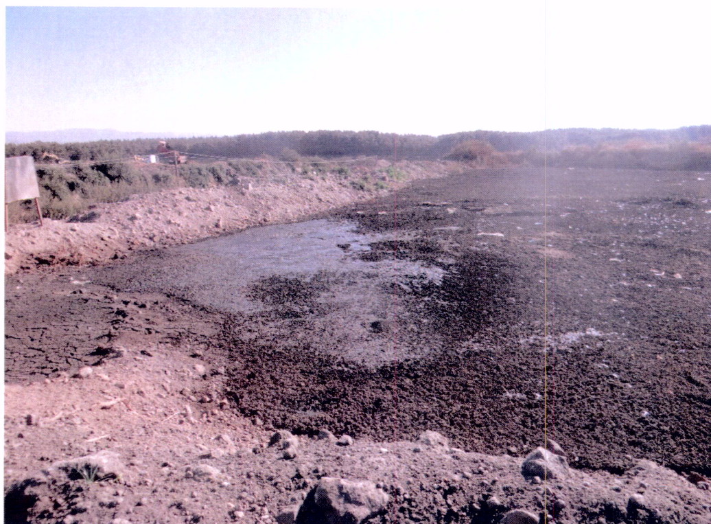
Figura 3. Sector de burbujeo de lodos, Piscina 4.
