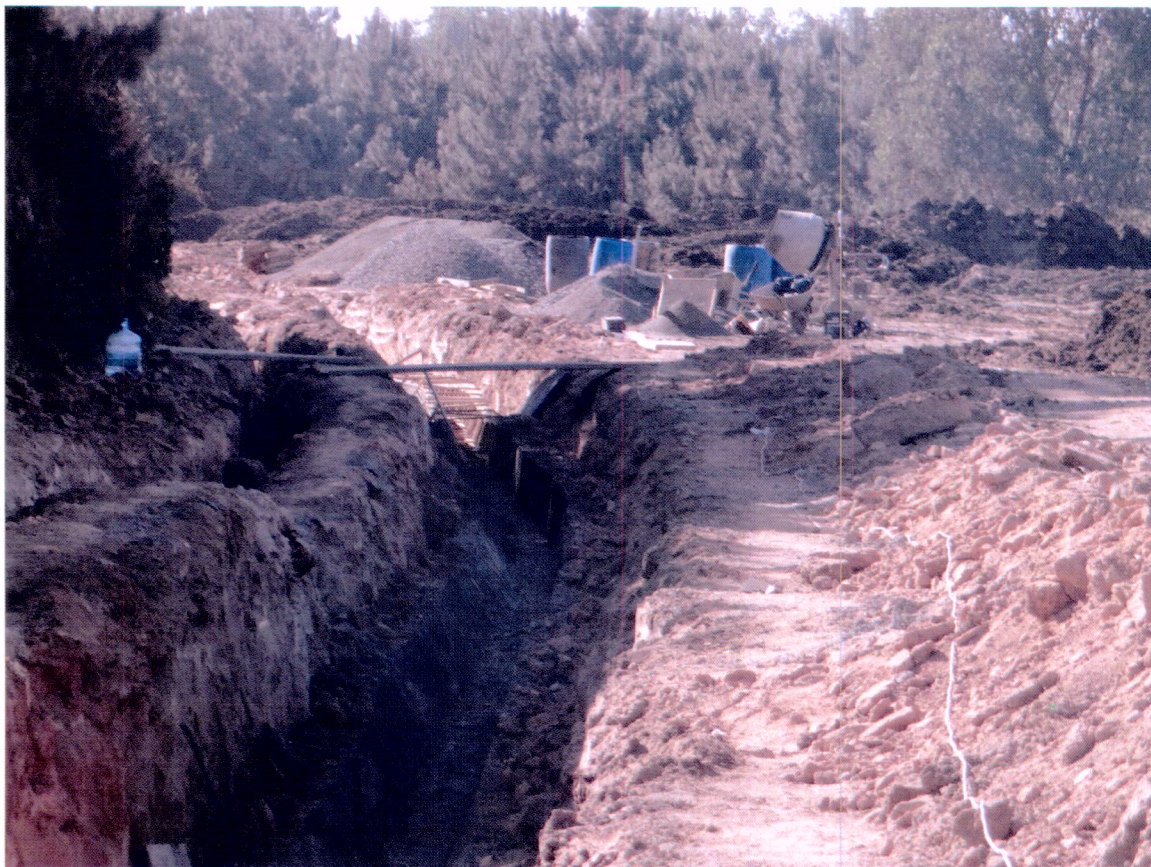
Figura 14. Vista de construcción de canales de contorno
