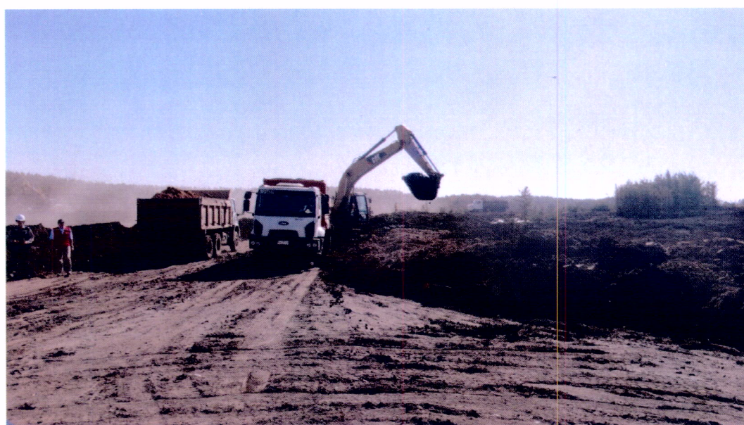
Figura 10. Vista retiro de lodos “piscinas de lodos de invierno”
