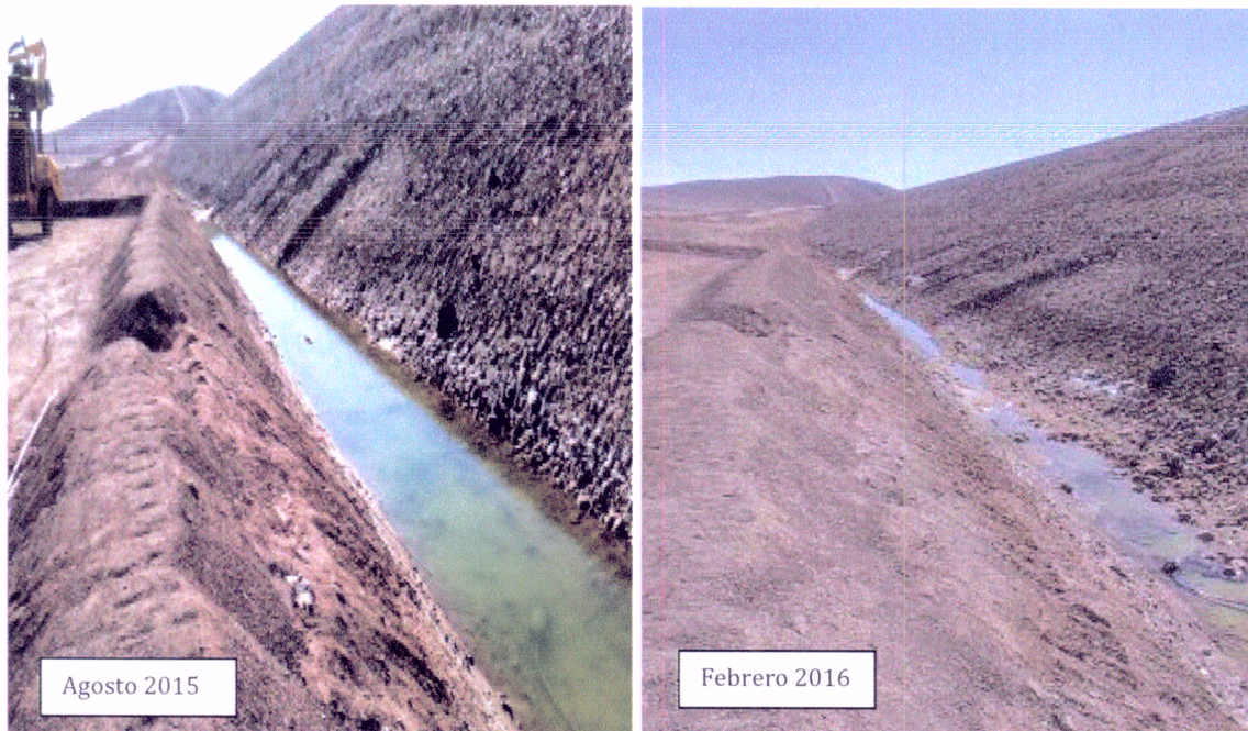
Figura 2: Zanja manejo infiltraciones Muro 4.
