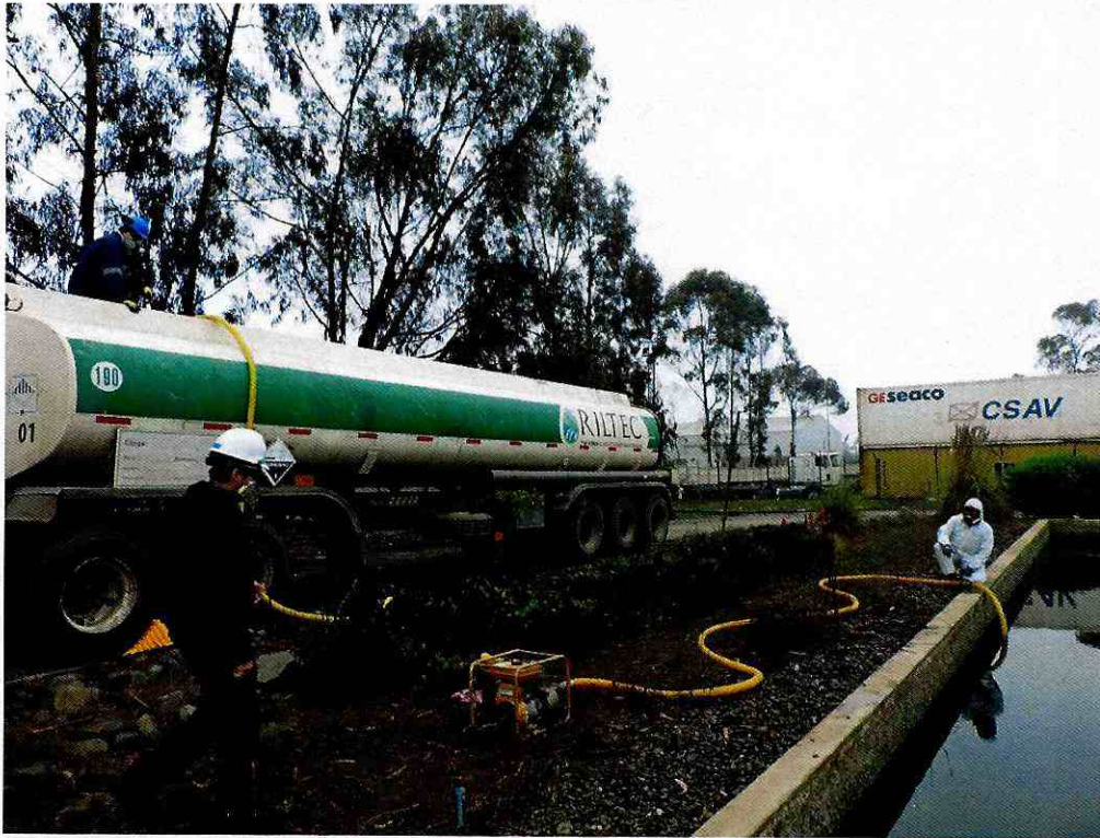
Figura - 1. Retiro de Residuos líquidos peligrosos por medio de bomba
