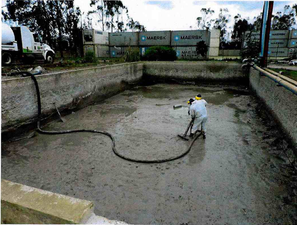
Figura - 2. Retiro de sedimentos en piscina norte, como residuo líquido peligroso
