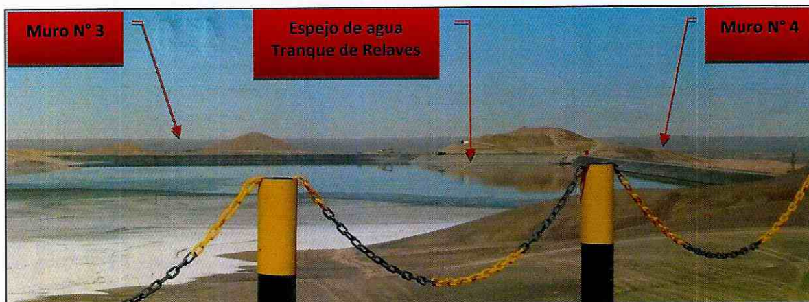
Figura 1. Laguna de aguas claras formada entre los muros 3 y 4 del depósito de relaves. Fecha 10 de septiembre de 2015.
