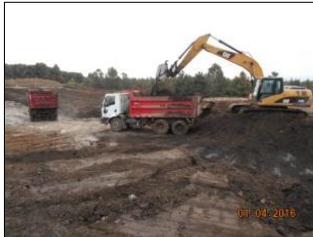
Vaciado de piscina sector 3 (35°12'16.16"S) (71°23'6.54"O)
