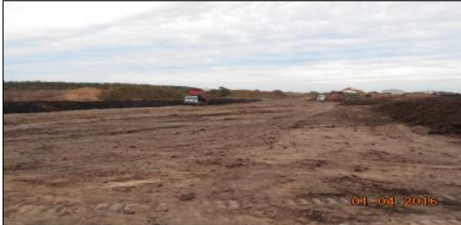
Conformación de pilas con lodos provenientes de piscina 3 y acopio de invierno (35°12'13.62"S) (71°23'9.97"O)
