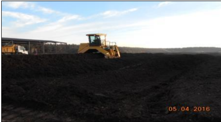
Conformación y secado de pilas lodos acopio invierno (35°12'19.46"S)( 71°23'20.40"O)
