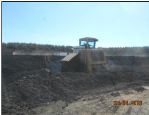
Conformación de pilas y secado de lodos del sector 3 (35°12'14.14"S) (71°23'3.76"O)
