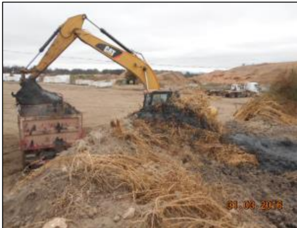
Vaciado acopio de invierno (35°12'20.79"S) (71°23'19.79"O)
