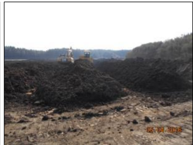
Conformación de pilas y secado de lodos del sector 3 (35°12'14.14"S) (71°23'3.76"O)
