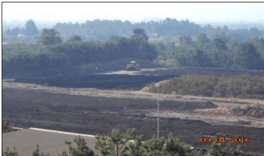
Conformación de pilas y secado lodos piscina 3 (35°12'14.14"S) (71°23'3.76"O)
