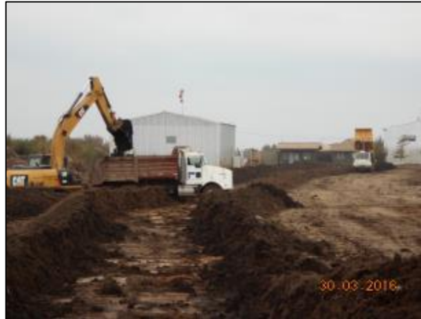
Vaciado acopio de invierno (35°12'18.27"S) (71°23'17.50"O)
