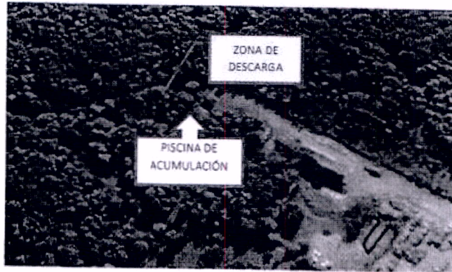
Detalle de zona de descarga de residuos líquidos.
