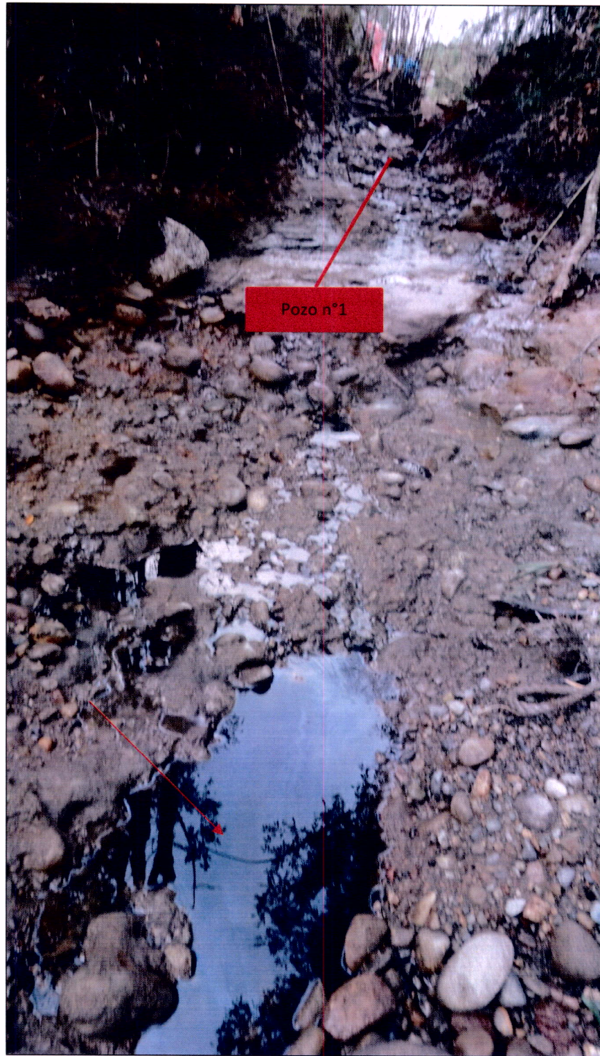
Fotografía N° 1: Se observa la canalización existente entre pozo n° 1 y n° 2, al fondo pozo N° 1, en primer plano residuo líquido con las mismas características observadas en fotografía n° 1 que escurre hacia pozo n° 2.
