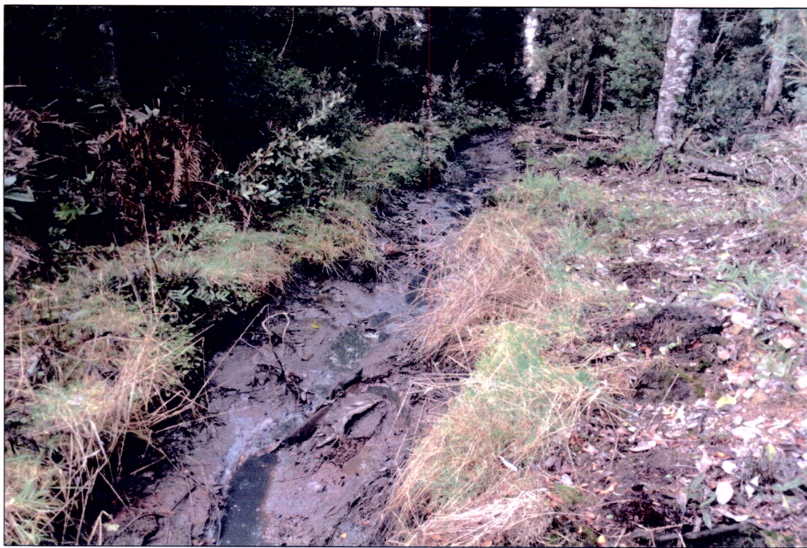
Fotografía N° 3: Se observa canalización existente para el escurrimiento de residuos líquidos desde el pozo n° 3 hacia la parte posterior del predio.
