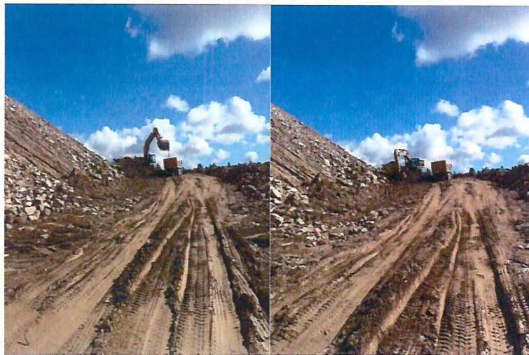
Figura N° 2. Ensanche del camino
