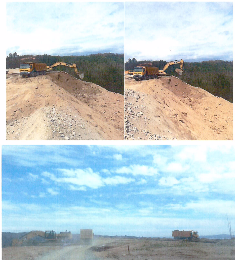
Figura N° 3. Conformación del Escalón N° 1.
