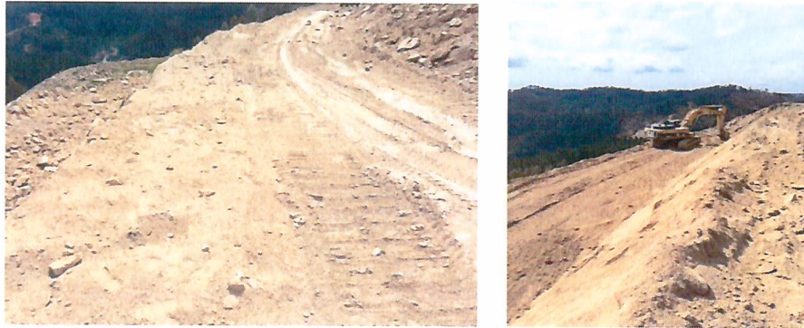
Figura N° 4. Conformación del escalón 2.
