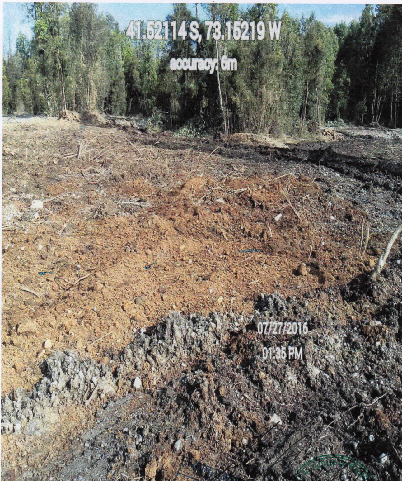
Foto muestra Pozo 1 se mantiene cerrado
