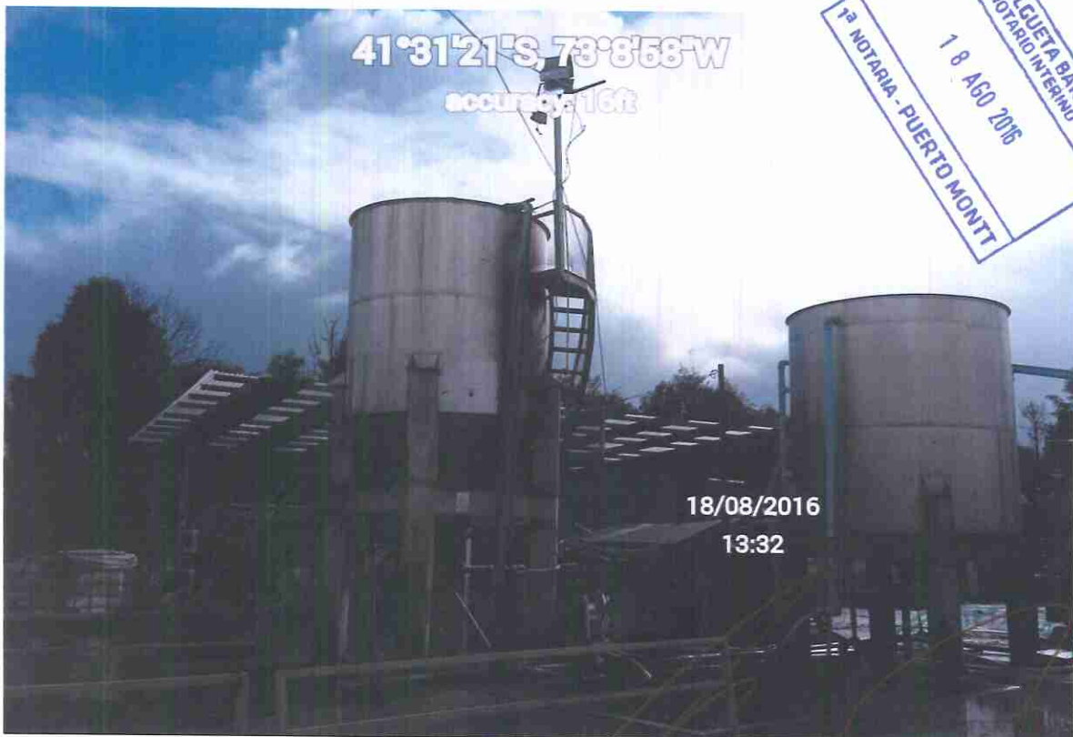
Planta de tratamiento sin funcionamiento
