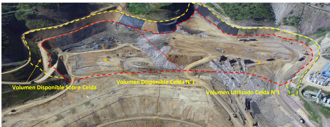
Figura 1 – Vista General Celda N°1 y Sobre-Celda
