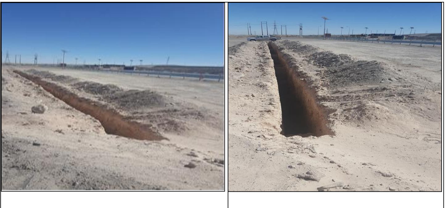
Imagen N°2: Calicata piscina fuente externa
