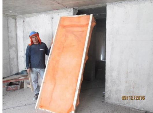
**Protección vanos interiores de los dptos. con placa de madera OSB y lana de vidrio.**
