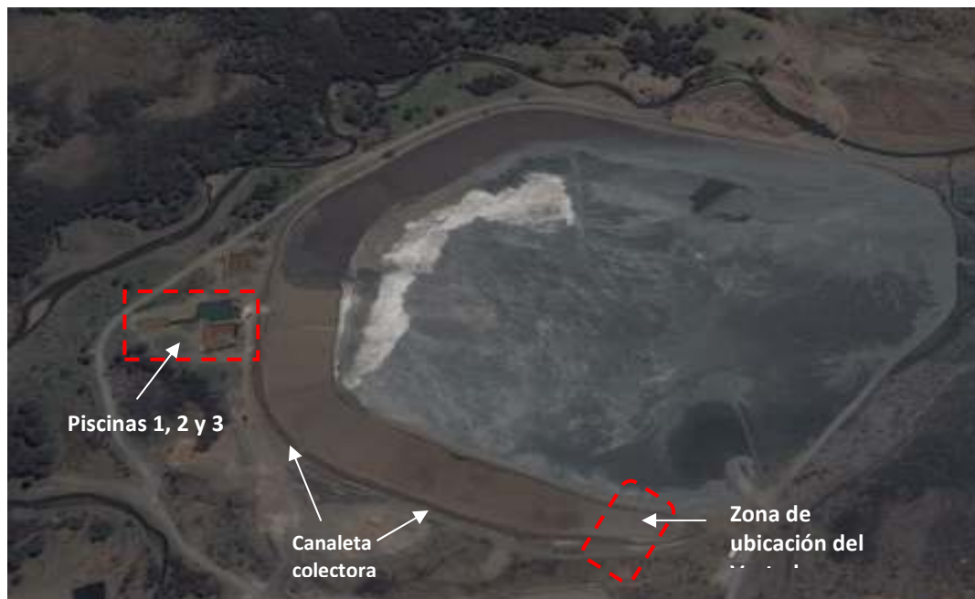
Figura N°1. Instalaciones de evacuación de aguas superficiales.
